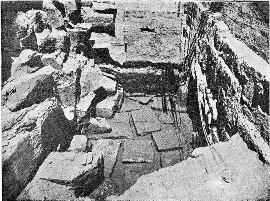
La dernière assise des fondations du III e pylône, aile nord, vues plongeantes.
