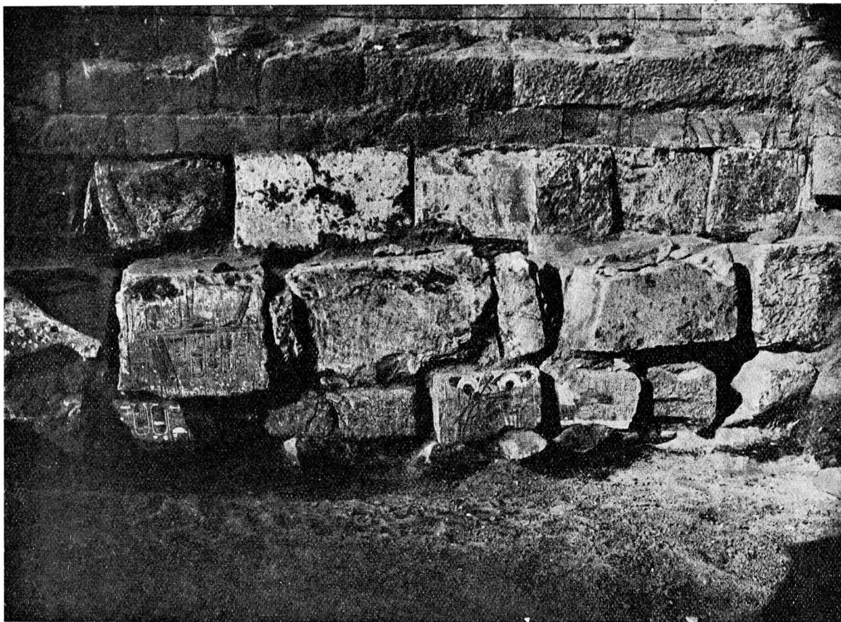
III e pylône. Fondation de la face Nord.
