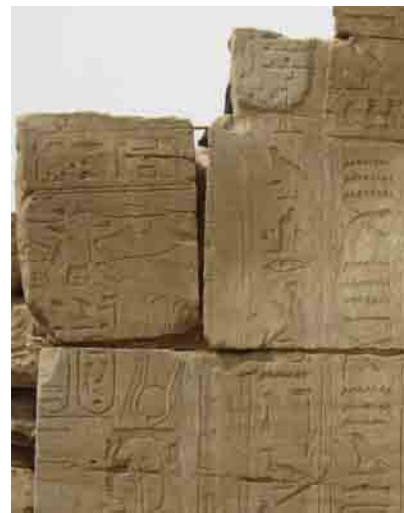
Montant nord de la façade du naos, après nettoyage et remplacement d'un bloc épars.
