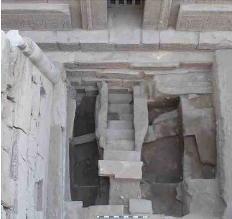
Escalier entre les temples d'Opet et de Khonsou (sondage 10).
