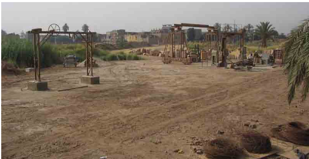
Débiteuse à fil en cours de remontage à l'extérieur de l'enceinte, côté oriental.
