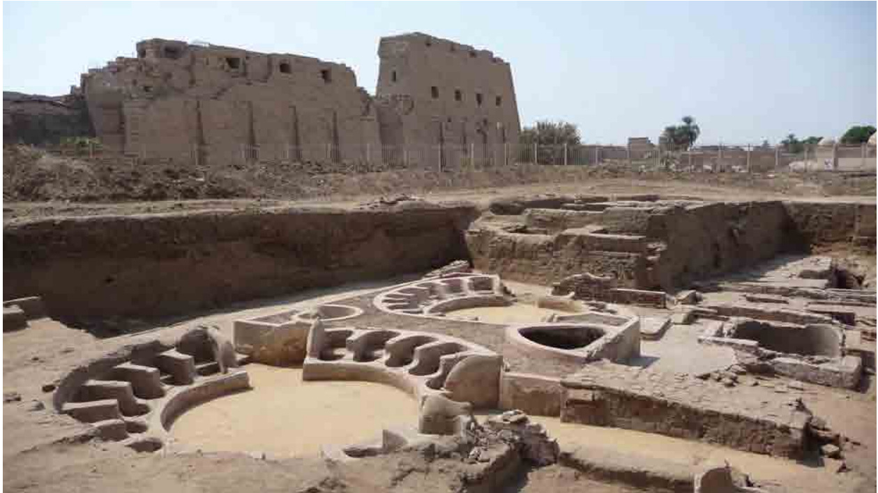
Vue générale des bains ptolémaïques en cours de restauration.
