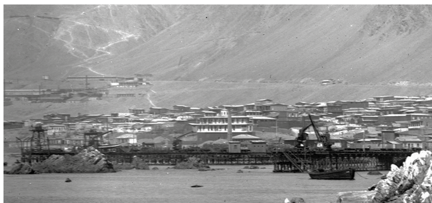
Figura 4: Vista de la Beneficiadora desde la Península de Algodonales en 1912. Se aprecia el conjunto de muelles, algunos de ellos implementados por Sloman. Fuente: archivo D. Galaz-Mandakovic.
