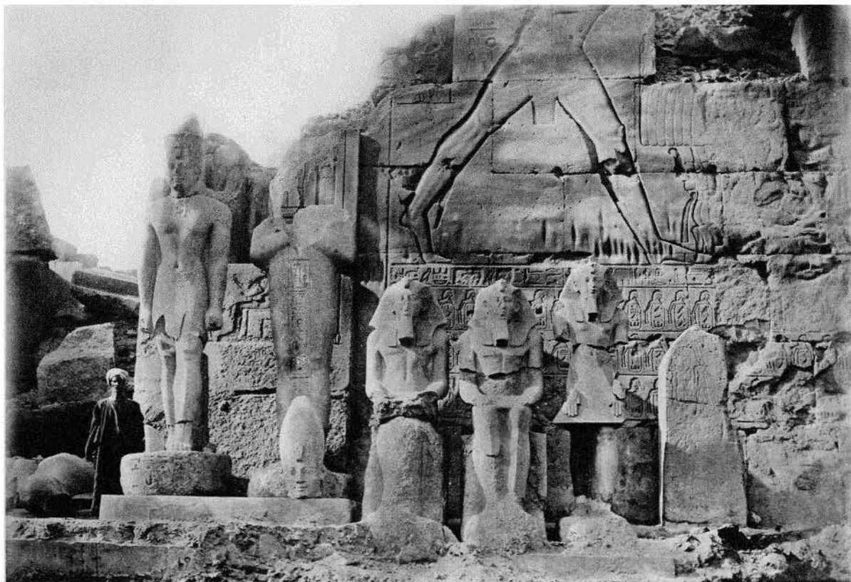
État actuel de l'aile droite du VII e Pylône.
