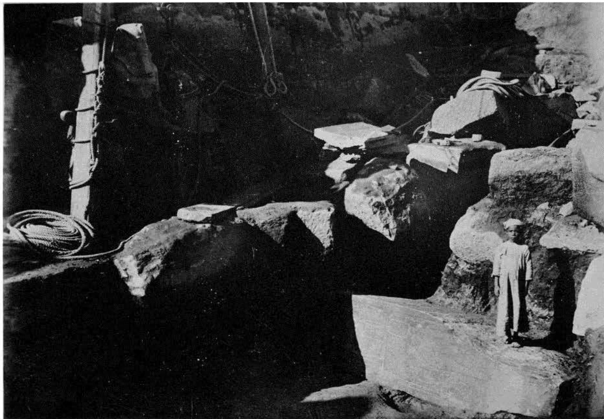
Emplacement du pilier d'Ousirtasen I er sous le sol de Thotmès III.
