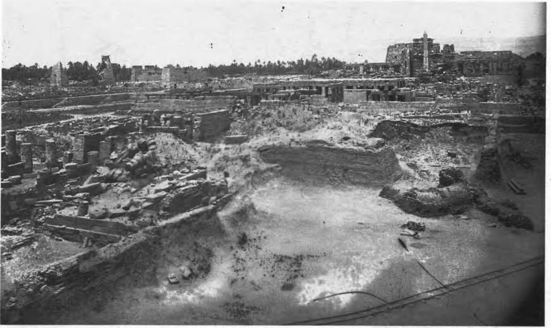
a. Vue générale de la zone en 1950 ( cliché H. Chevrier ).
