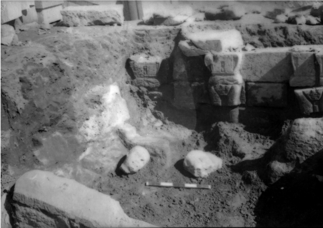
Fig. 3. La chapelle au moment de la découverte (1958-1959), paroi extérieure nord © Cnrs-Cfeetk/93793.
