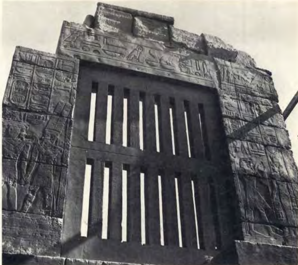
Pl. III a. Le grand hypostyle. Fenestration et corniche restaurés à la jonction de la première travée latérale nord avec le vestibule du III e pylône.
