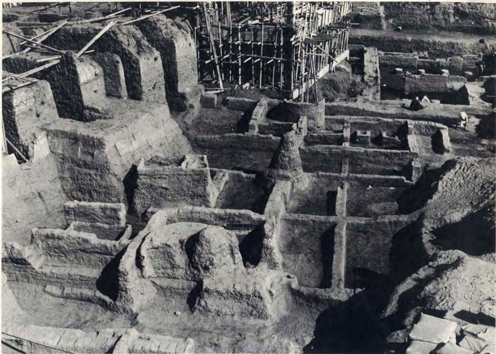
Pl. XII Fouilles à l'est du lac sacré (état à l'arrêt des travaux).
