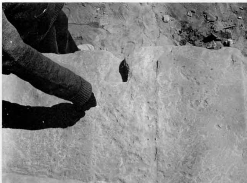
Fig. 4. Aspect des canaux horizontaux creusés au milieu des assises. (Remarquer la queue d'aronde, preuve que le bloc voisin a été arraché).
