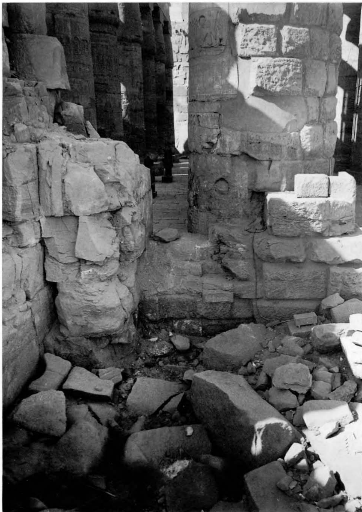
Fig. 1. Aspect de la partie sud du vestibule du III e pylône avant les travaux. (Le sol est jonché de nombreux fragments d'obélisques, actuellement rangés à l'intérieur du môle nord).
