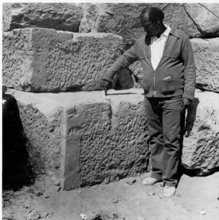
Fig. 3. Aspect des joints verticaux du montant sud de la porte du III e pylône : la partie centrale disjointe est évidée et mal dégrossie afin de faciliter l'accroche du mortier versé après la pose, par les petits canaux de coulée verticaux visibles ici. Le cadre d'anathyrose peut être distingué sur les blocs de parement ayant conservé leur bossage.
