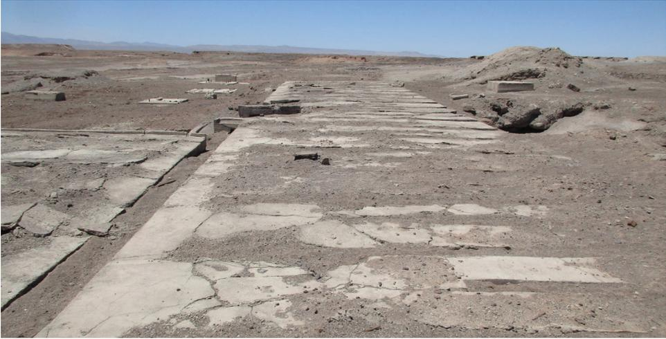
**Figura 7.** Detalle de la plataforma que servía de base para los cachuchos de lixiviación.
