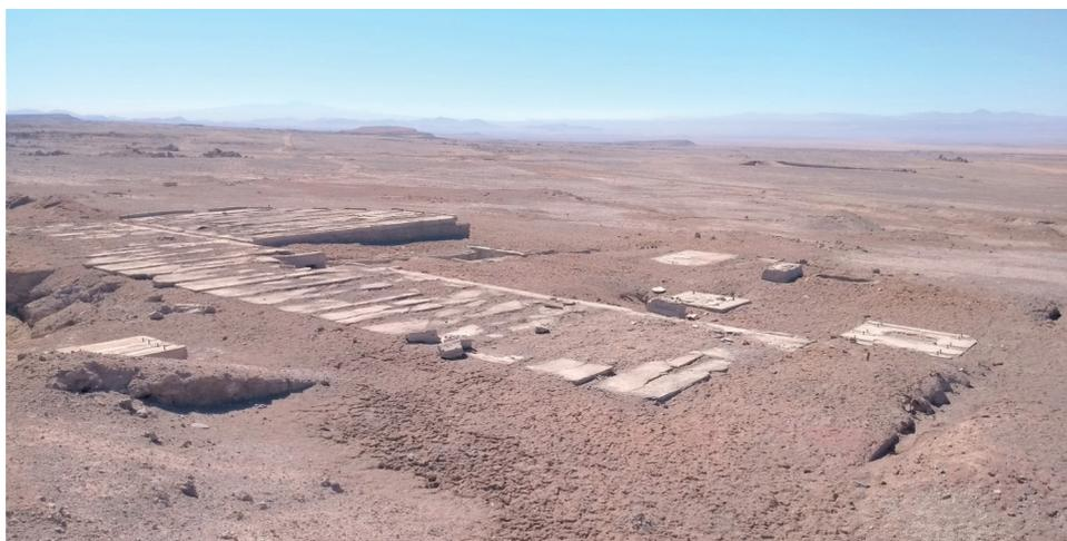
**Figura 6.** Vista general de la plataforma que servía de base para los cachuchos de lixiviación.
