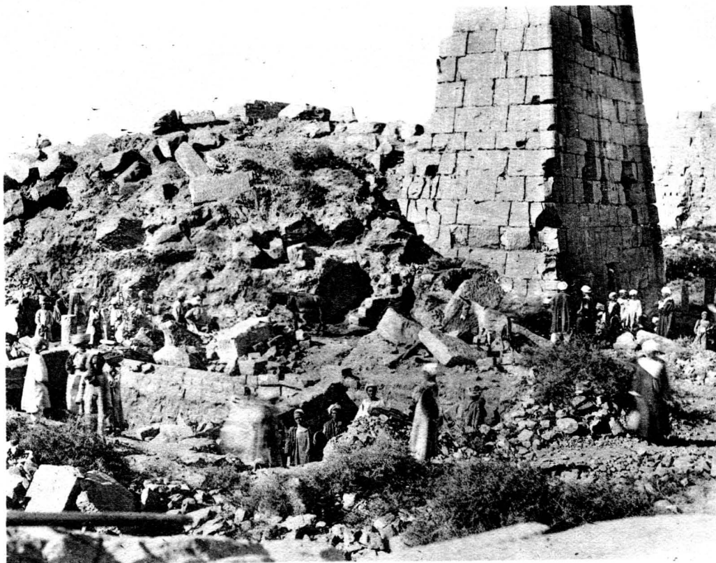
1. — IX e pylône. Angle sud-est pendant les travaux, le 25 Février 1922.
