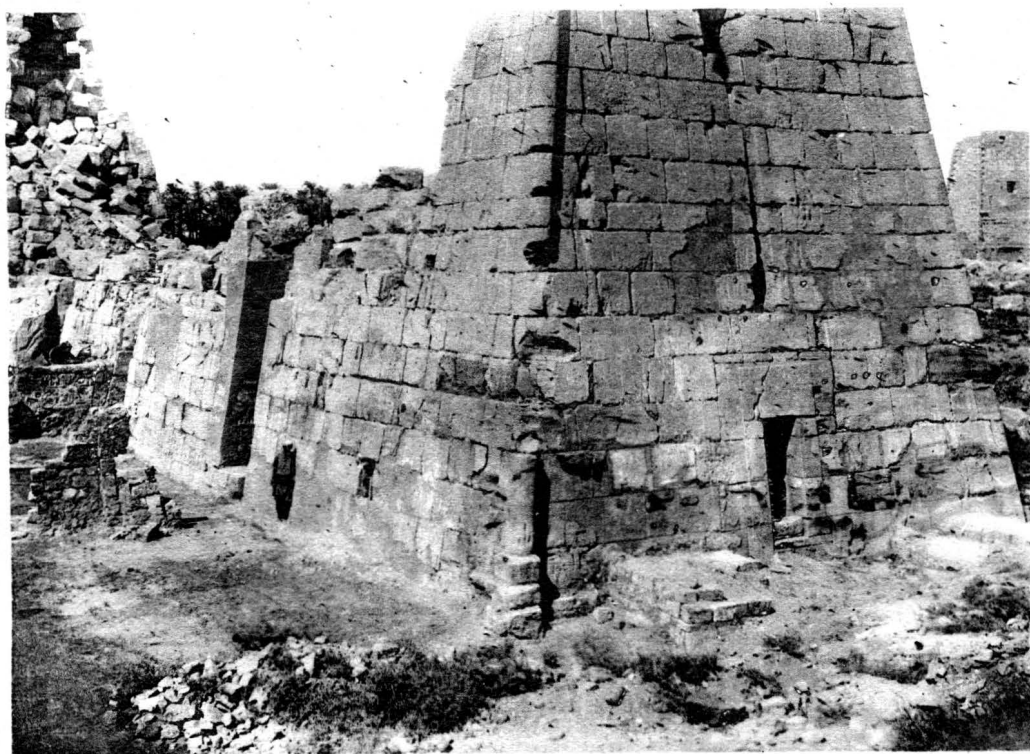
2. — IX e pylône. Angle sud-est après les travaux, en Avril 1922.
