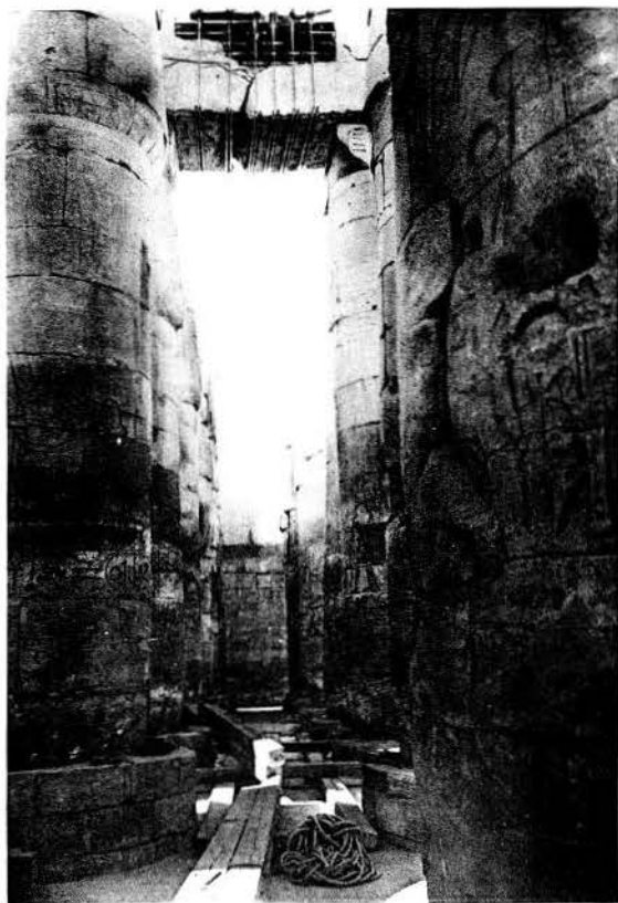
Architrave de la Salle Hypostyle, consolidation provisoire.
