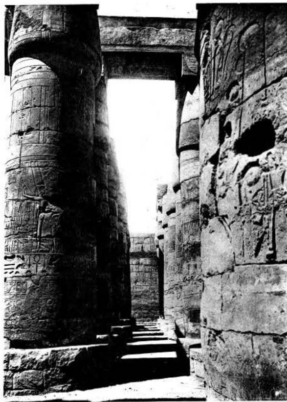
Architrave de la Salle Hypostyle, consolidation définitive.
