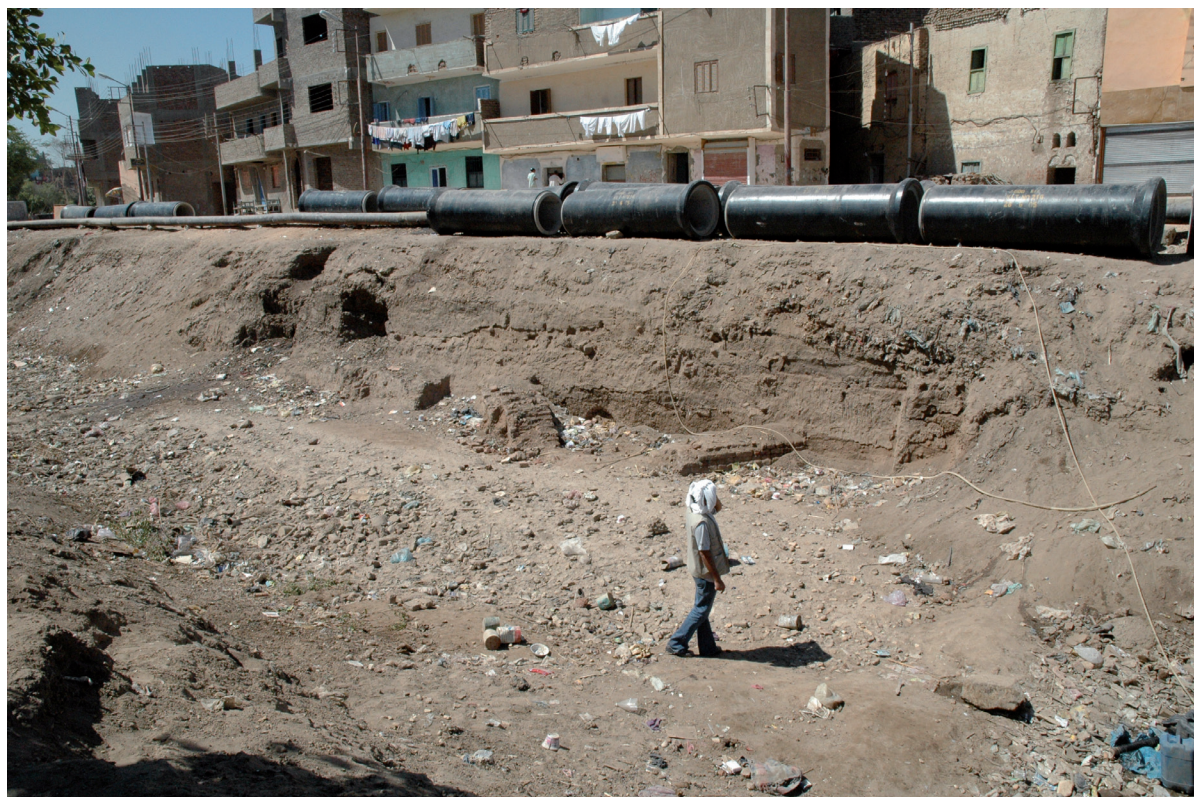
Fig. 3. Vestiges de la structure A visibles dans la pente du drain Chevrier avant la fouille © M. Boraik.
