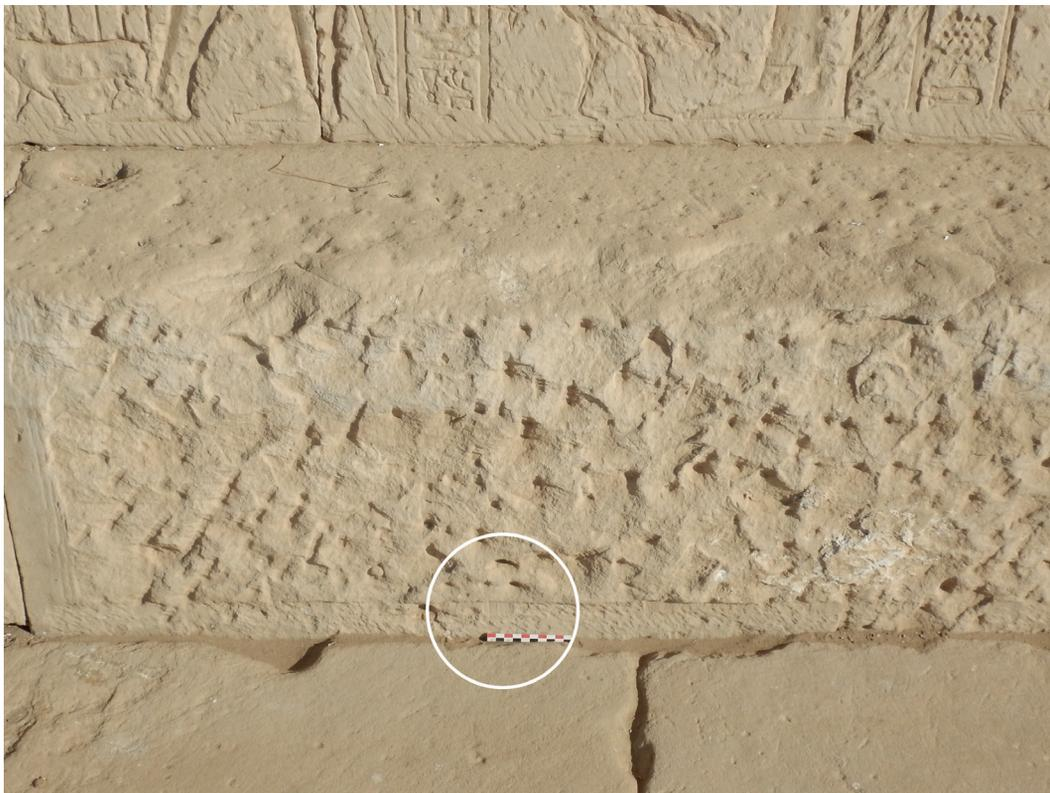
**Fig. 25.** Dendara, temple d'Hathor, assise de réglage de la façade sud du naos, détail d'un repère de « ravèlement » sur le bandeau préparé pour la liaison avec le dallage de l'espace périmétral.
