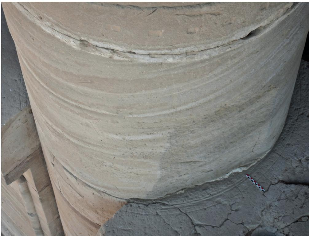
**Fig. 20.** Dendara, mammisi « romain », portique occidental, colonne au nord de l'axe transversal, détails des repères de ravèlement au niveau des liens horizontaux dans la partie supérieure entre le mur d'entrecolonnement et le chapiteau.
