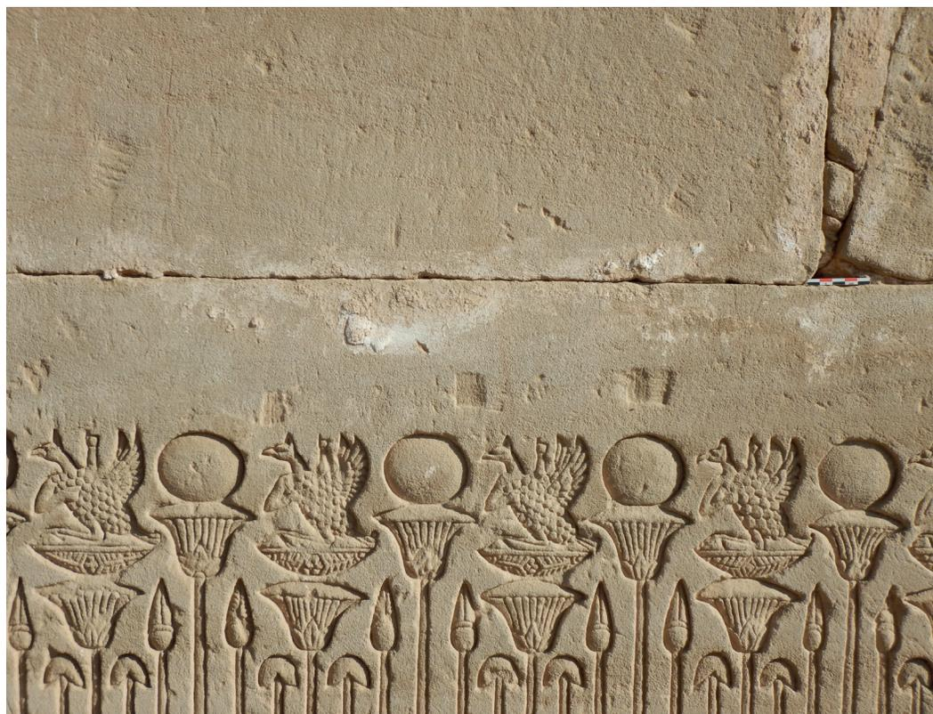
**Fig. 2.** Dendara, mammisi « romain », extérieur ouest, détail de repères de ravalement au-dessus de la frise basse (second entrecolonnement en partant du sud).
