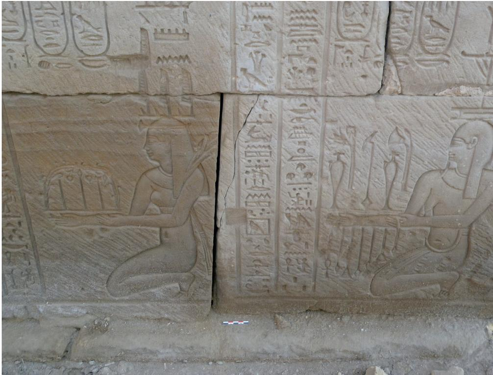
**Fig. 12.** Karnak, temple d'Opet, façade nord, détail d'un repère de ravalement dans l'épigraphie. Remarquer la ciselure périmétrale trop profonde du joint supérieur du même bloc.
