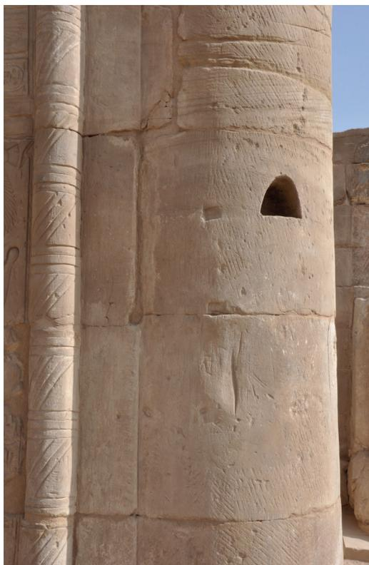
**Fig. 17.** Karnak, temple de Ptah, kiosque de la rénovation de Ptolémée III, détails de repères de ravèlement apparents sur la surface finie du fût (colonne sud-ouest).
