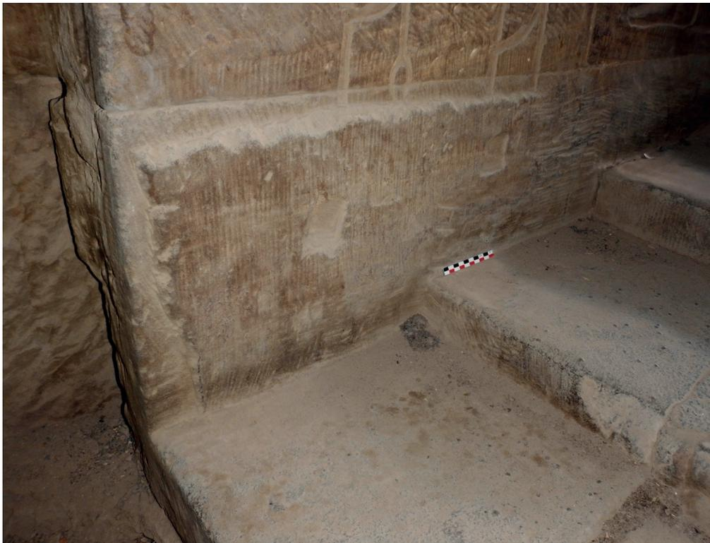
**Fig. 16.** Edfou, temple d'Horus, bas de l'escalier longitudinal ; côté ouest, détail du bas de la paroi avec son ravalement inachevé et deux repères dans la surface en partie démaigrie.
