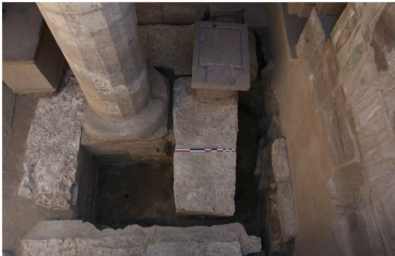
Fig. 17. Côté sud de la cour, dalle de couverture avec corniche visible au premier plan © Cnrs-Cfeetk/P. Zignani.
