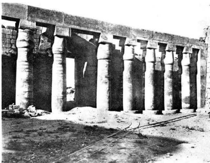
Partie de la colonnade nord de la Grande Cour consolidée et complétée cette année.
