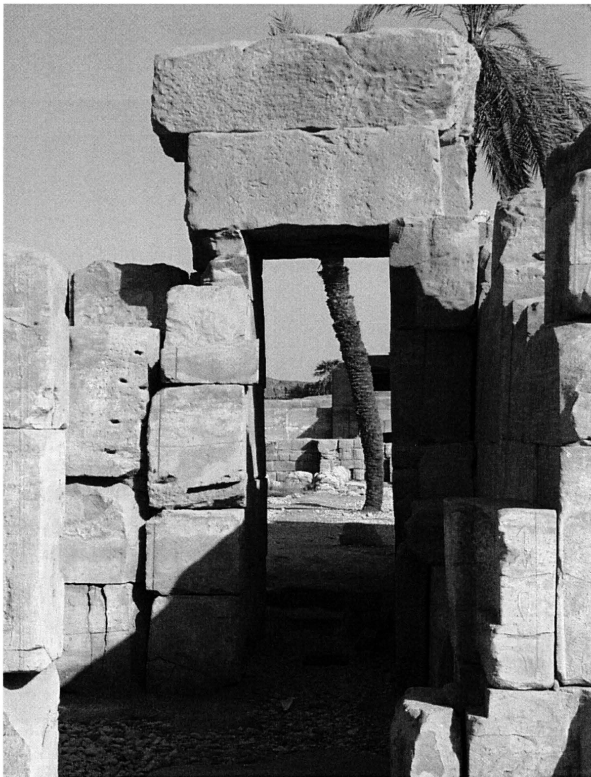
Pl. 3 : Joint entre l'ancienne et la nouvelle maçonnerie au débouché ouest du corridor.
