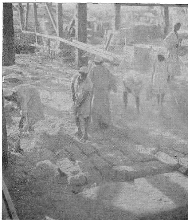
L'intérieur du 9 e Pylône : enlèvement de la couche de plâtre et de débris de pierre recouvrant le onzième lit des pierres remployées.
