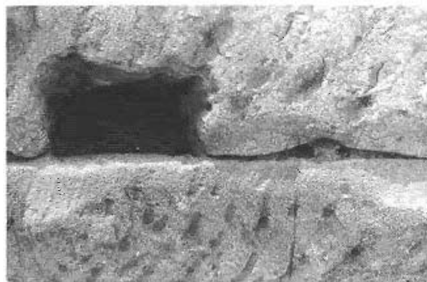
Détail d'une encoche d'ascension sur l'élévation est, avec sur l'assise inférieure le tracé de construction de l'axe de symétrie.
