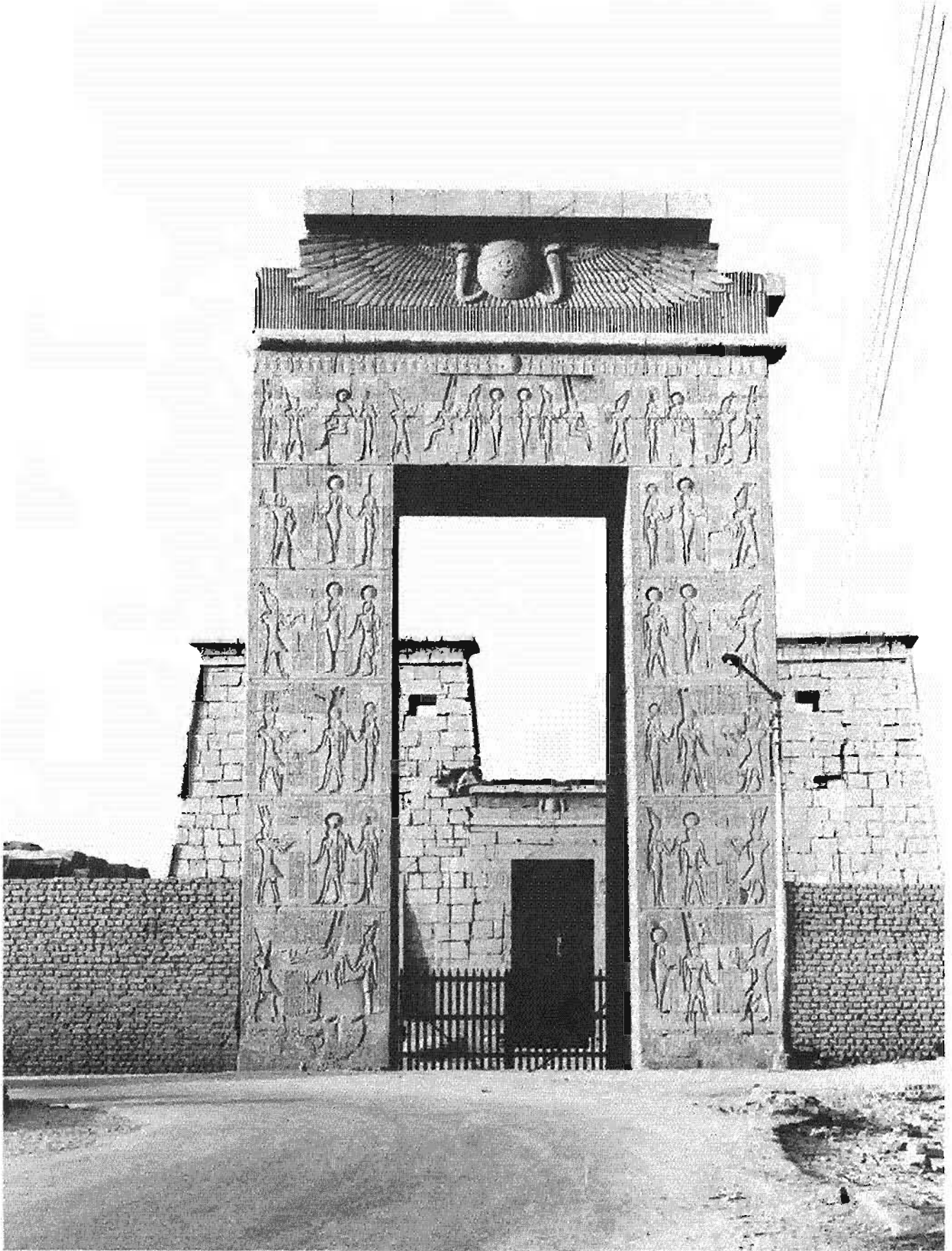
Façade extérieure (© CNRS/CFEETK, J. Gallet).
