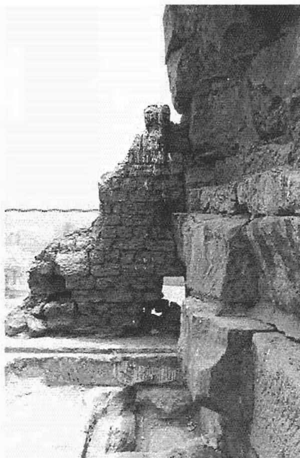
b. Mur occidental de l'espace entre les deux corniches.
