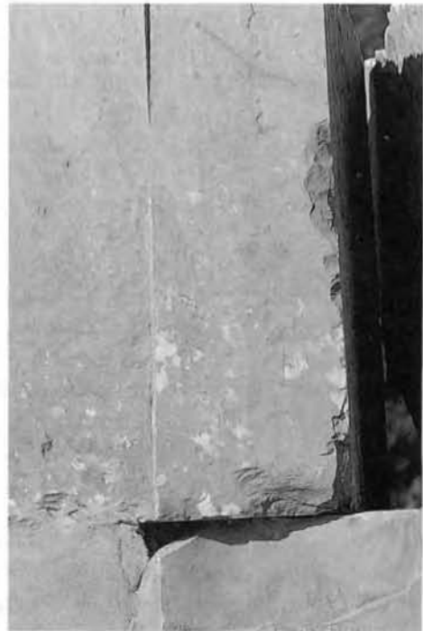
E) Traces d'outils de ravalement sur la face intérieure du mur nord de la cour, près de son extrémité ouest. Changement de pente de la paroi consécutif à l'amincissement du mur à l'endroit où il longeait la face nord du pylône.
