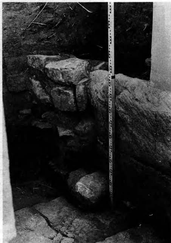
b. Jambage sud du passage de la porte de Masaharté, avec la crapaudine au pied de la feuillure du montant sud-ouest.
