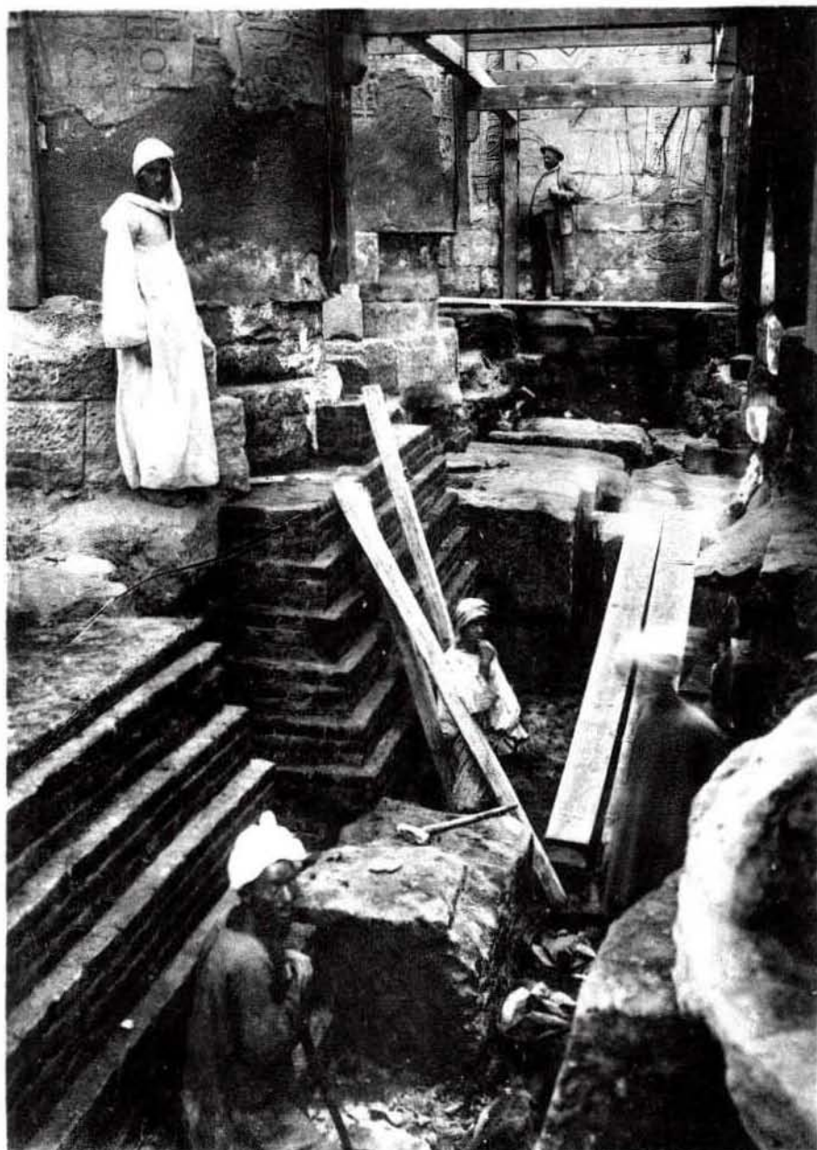
Karnak. — Réfection des fondations de la Salle hypostyle.
