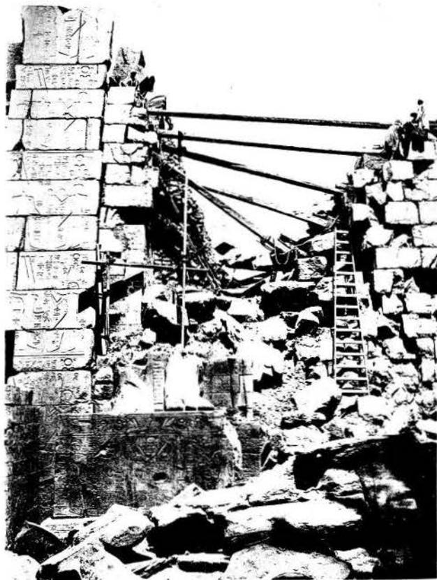
1. — X<sup>e</sup> pylône. La pile S.-E. vient d'être redressée, 15 avril 1923.
