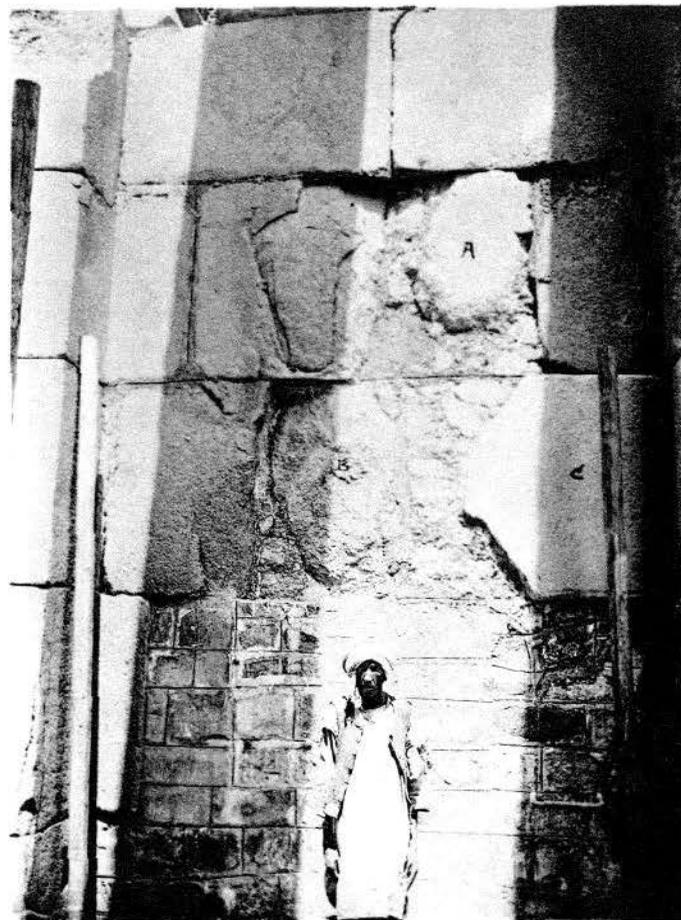
2. — Xe pylône. L'éboulement est remonté, la paroi refaite, 30 avril 1923.
