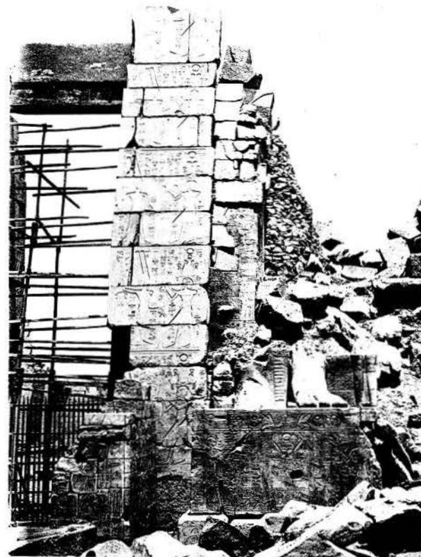
2. — La pile S.-E. est en place et reprise en sous-cœuvre, 30 avril 1923.
