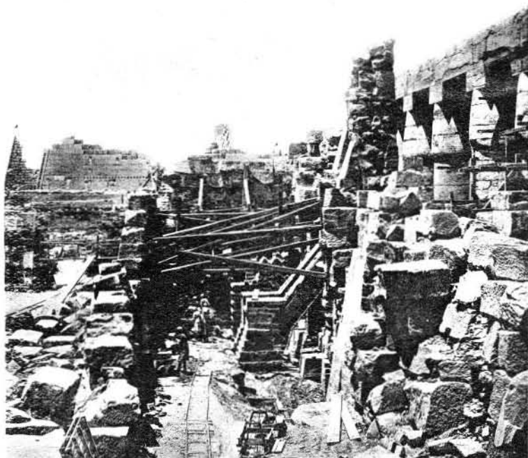
III e pylône, état en Juin 1929.
