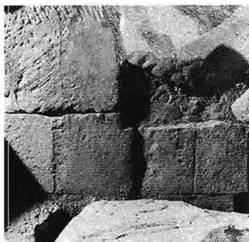
c. Le tracé de pose de la niche n° 7 du môle sud du IV e pylône.
