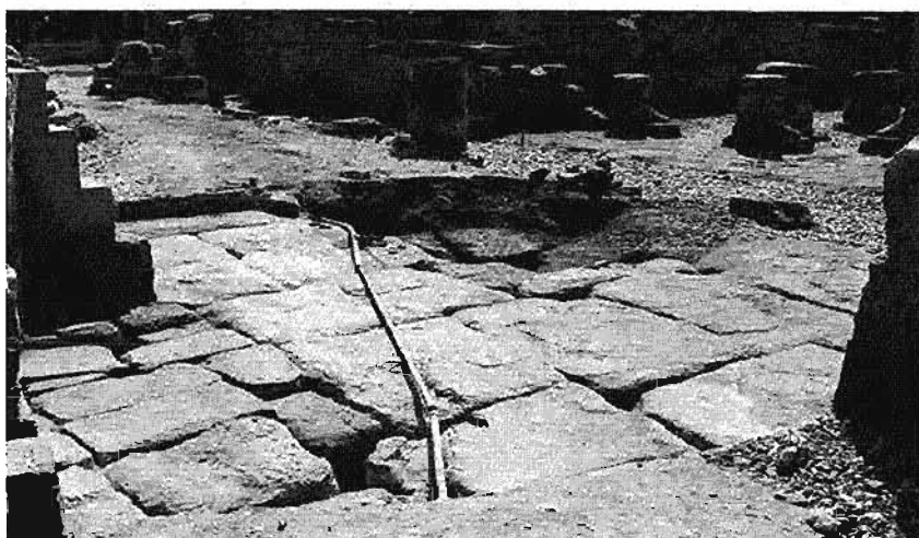
b. Fondations à l'angle nord-est de la Ouadjyt .
