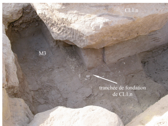
b. M3 recoupé par la tranchée de fondation de CL1.n. Vue vers le sud. © Cnrs-Cfeetk, n° 68381.
