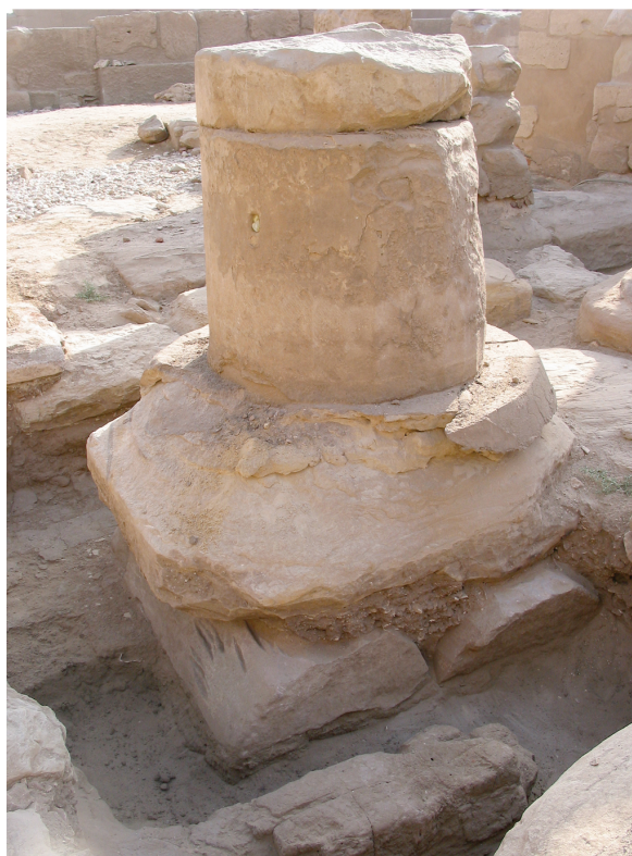
a. Les fondations CL1.n constituées de deux demi-tambours en grès. Vue vers l'est. © Cnrs-Cfeetk, n° 68392.
