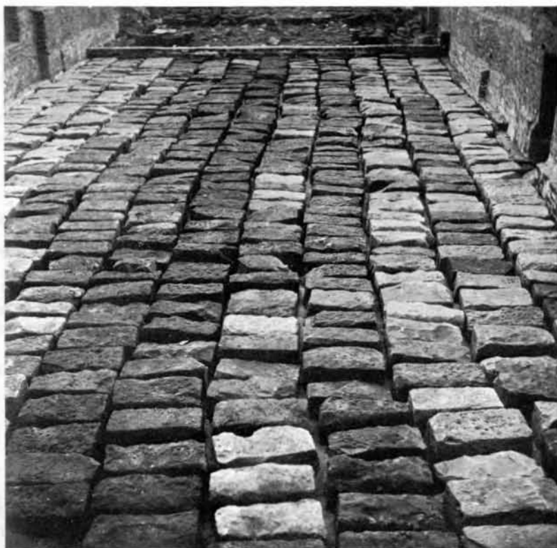
Pl. XVI (a et b). Pose des nouvelles couches de talâtât : en haut, couche 36 d'orientation Est-Ouest, en bas couche 35 terminée. Cl. M. Azim.
