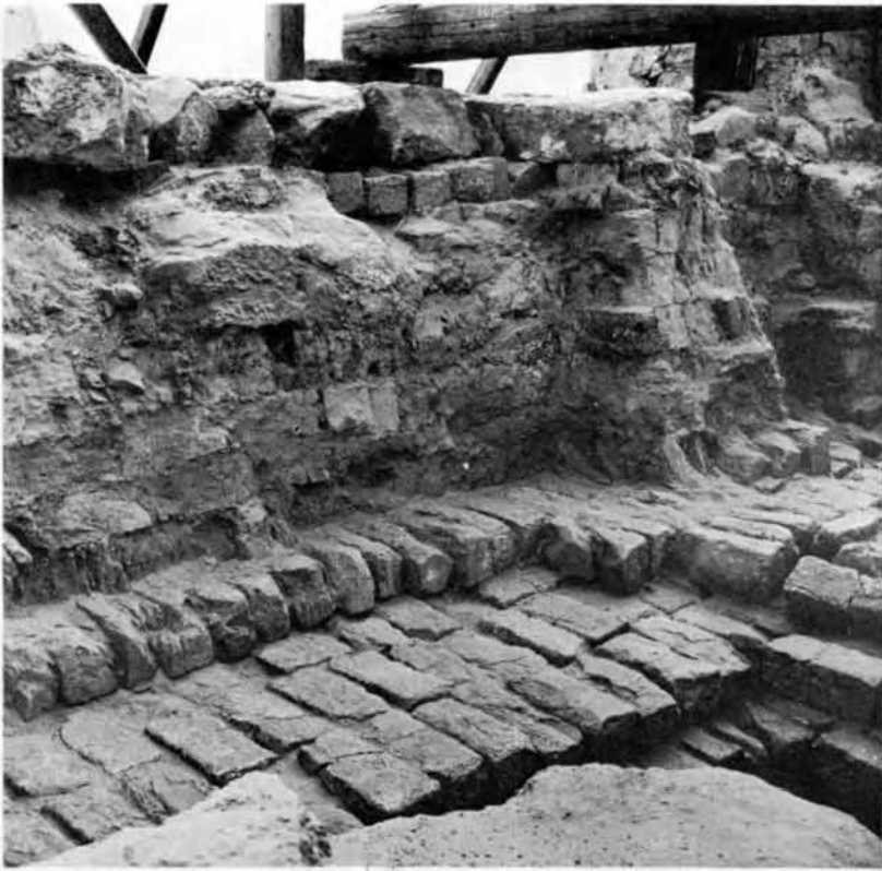
Pl. VII/a. Aspect des contre-parements à la fin de la première tranche de travaux, en juin 1978. Cl. M. Azim.
