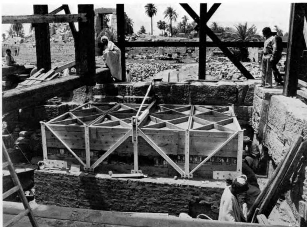
Pl. XII (a et b). Le bloc sud de Sésostris I er enfermé dans son châssis, puis en cours de levage. Cl. A. Bellod.
