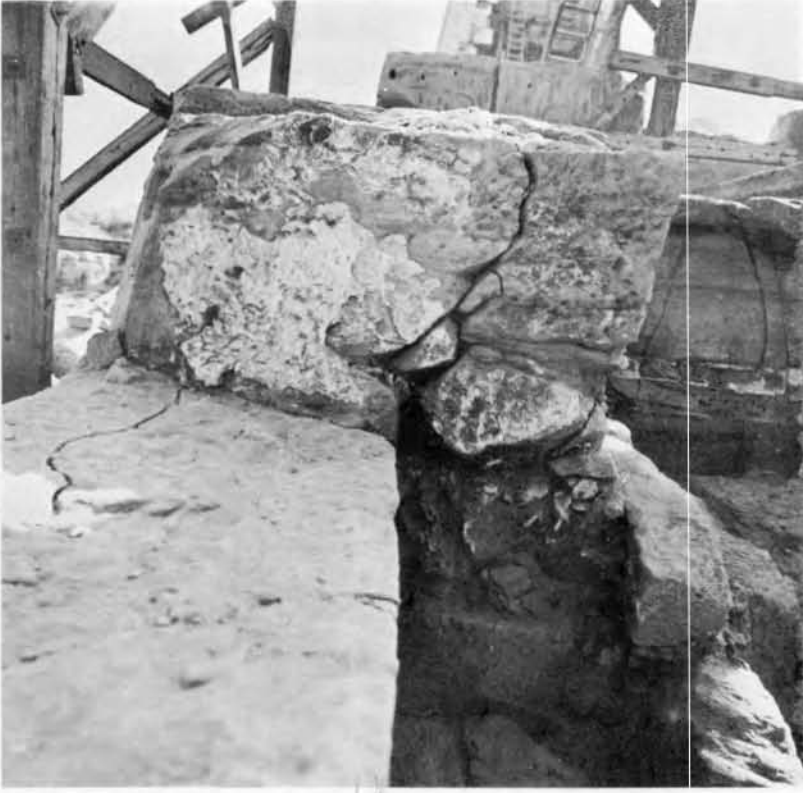
Pl. V/a. Calage en terre et gravats d'une architrave employée dans l'angle nord-est du môle ouest, à l'assise 31. Cl. M. Azim.
