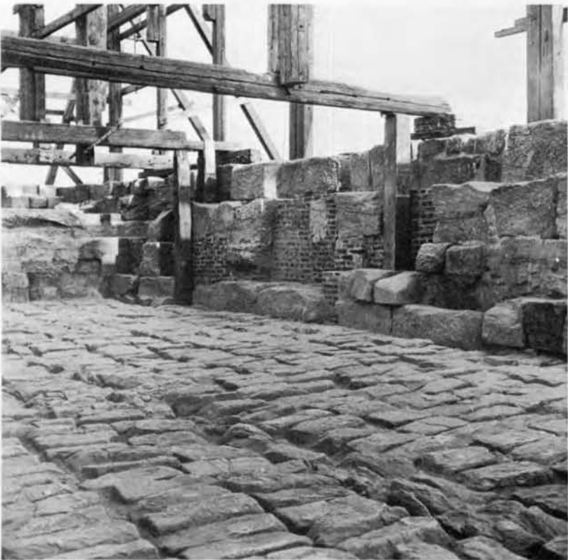
Pl. VII/b. Etat du chantier le 15 février 1979, après élimination des contre-parements et des lignes de grands blocs divisant le pylône. Cl. M. Azim.
