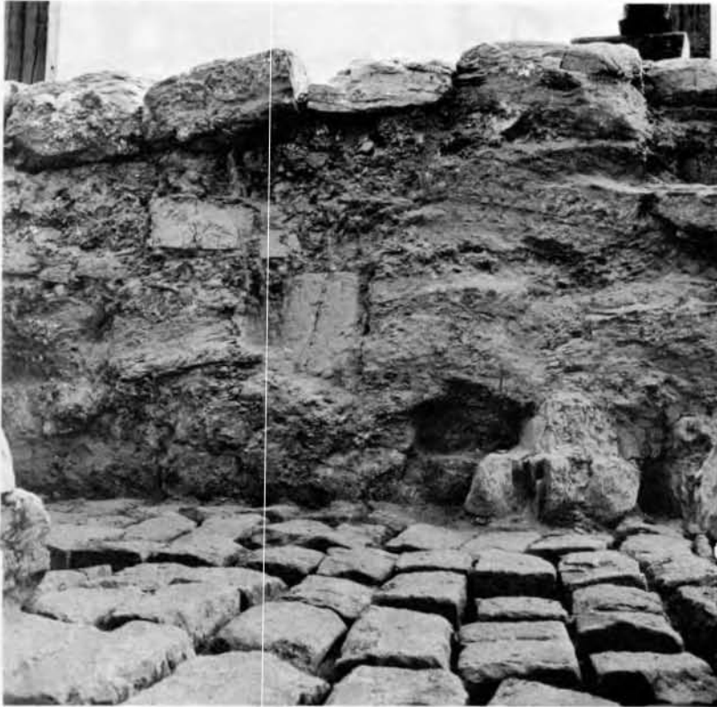
Pl. IV/a. Etat du « contre-parement » au-dessus de la couche 26, mêlant grands blocs, talâtât, poches de terre et de gravats. Cl. M. Azim.
