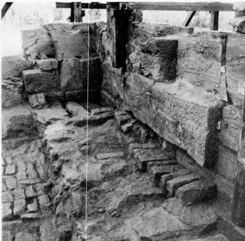
Pl. IV/b. Architraves remployées dans le montant ouest de la porte axiale du pylône, et dans le retour d'angle du môle au Nord. Cl. M. Azim.
