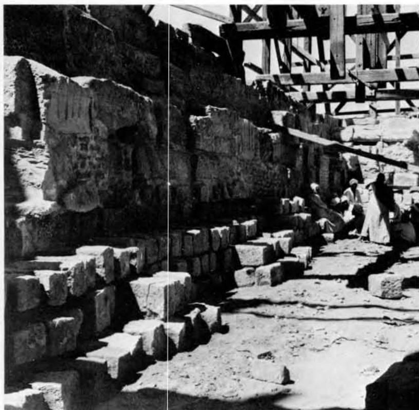
Pl. X (a et b). Les talât engagées sous les contre-parements sont extraites sur de courtes longueurs pour pallier tout danger d'effondrement, et immédiatement remplacées par une maçonnerie ; de proche en proche, un soutènement continu est établi. Cl. M. Azim.
