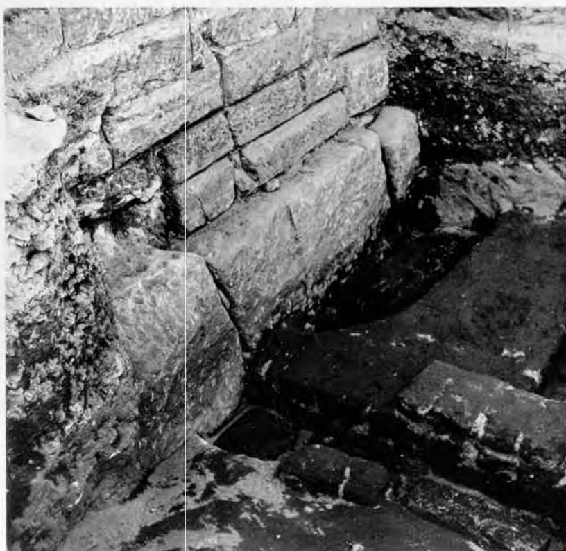
Pl. XIV/b. Fondation du montant est de la porte axiale du IX e pylône. Les grands blocs visibles en partie basse font partie de la construction d'origine, les assises minces au-dessus étant des restaurations antiques. En fond de fouille, vestiges de la structure de brique dégagée. Cl. M. Azim.
