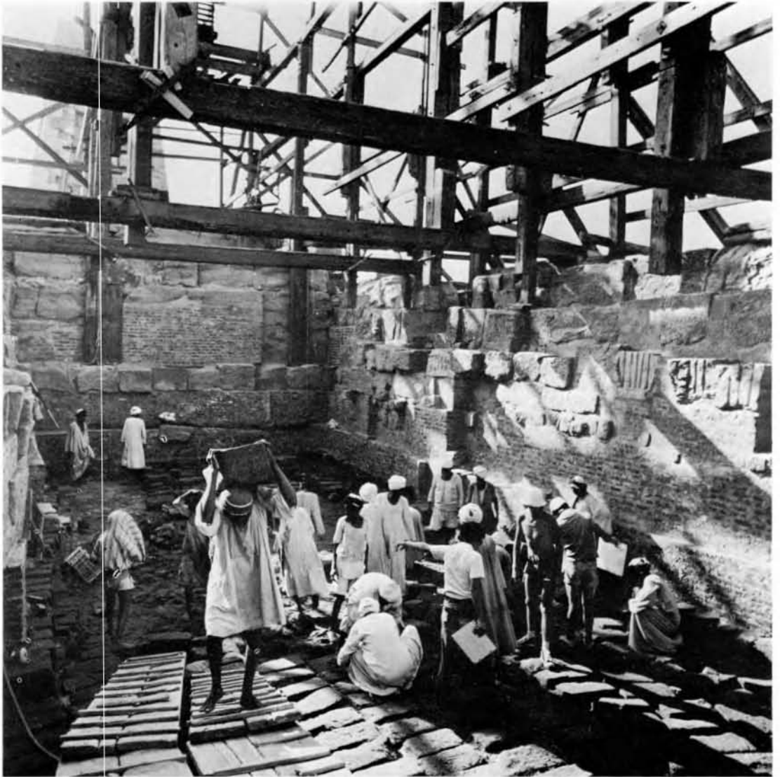
Pl. IX. Le chantier en cours : les pierres décorées sont momentanément stockées au fond du pylône après repérage, et les pierres anépigraphes évacuées à l'extérieur au fur et à mesure de leur extraction. Cl. A. Bellod.
