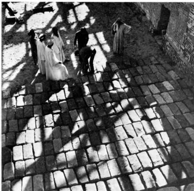
Pl. XVI (a et b). Pose des nouvelles couches de talâtât : en haut, couche 36 d'orientation Est-Ouest, en bas couche 35 terminée. Cl. M. Azim.
