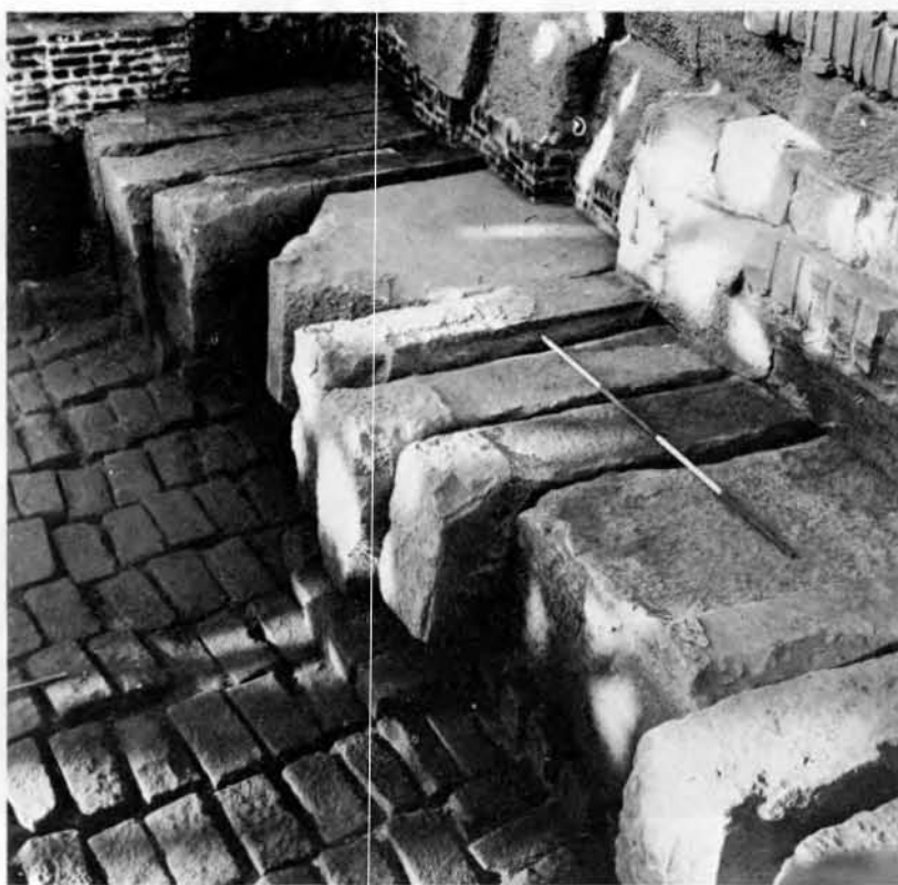
Pl. XIII (a et b). Architraves et dalles de couverture employées en fondation de la face latérale ouest du pylône : en a, saillantes à l'intérieur, et en b à l'aplomb de la fondation à l'extérieur. Cl. M. Azim-A. Bellod.
