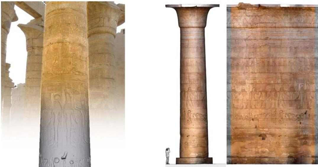
Scan 3D des colonnes et déroulé d'une colonne de la salle hypostyle.
