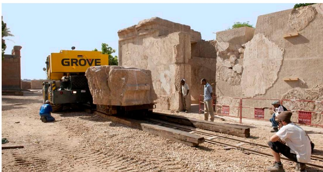
Déplacement d'un bloc de couverture de la chapelle de Thoutmosis III (© Cnrs-Cfeetk/J.-Fr. Gout).
