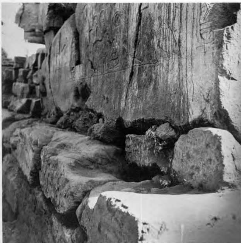
Pl. X, a. Calage du bloc ouest du caisson de quartzite du colosse occidental sur sa base de grès par l'intermédiaire de fragments parfois saillants de granit et de grès. Ces calages devaient être à l'origine masqués par une banquette rehaussant le pourtour de la base de grès. Cl. M. Azim.
