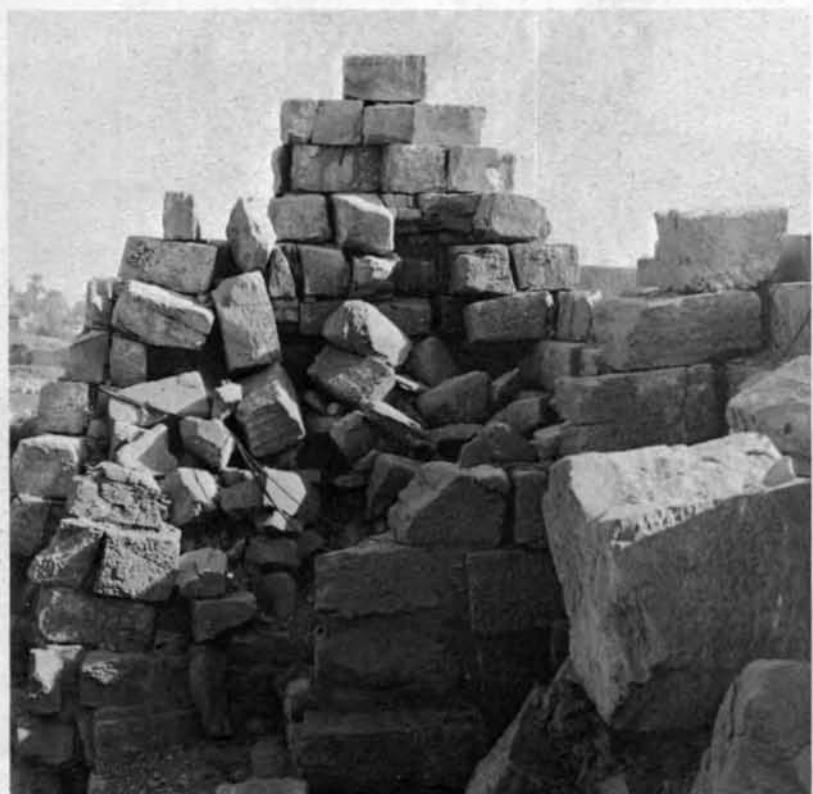
Pl. IV, b. L'extrémité nord du II e pylône montrant l'écroulement de ses parements vers l'intérieur. Un peu en avant (moitié droite de la photo), vestiges de l'un des murs de refend. Cl. M. Azim.
