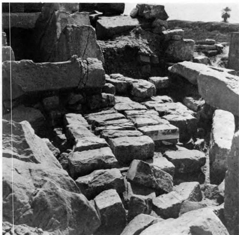
Pl. VII, a. Les premières couches de talâtât au sommet actuel du môle est du IX e pylône. On notera la construction de l'escalier, directement calé sur ces couches. Cl. M. Azim.
