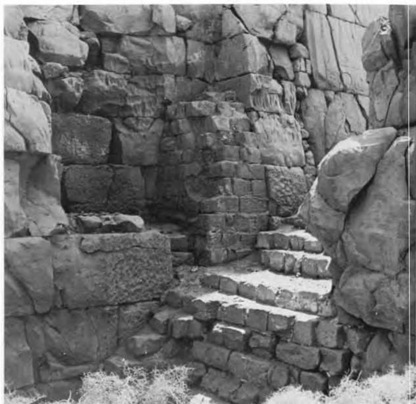
Pl. XI, a. Pile de talâtât élevée dans l'encoche initialement prévue, à l'Ouest de la porte de granit. Deux des faces de cette encoche sont nettement visibles aujourd'hui au-dessus de la pile de talâtât. A gauche de celle-ci, l'encoche retaillée à l'époque d'Horemheb présente un fond concave non ravalé. Cl. M. Azim.
