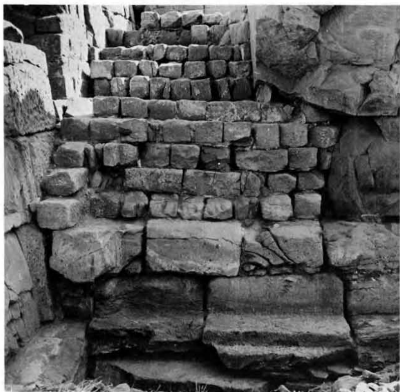
Pl. IX, a. Maçonnerie de talâtât reliant l'arrière du socle occidental à la façade du pylône, en saillie et non ravalée là où elle était masquée. Sous cette maçonnerie et le socle, deux assises de blocs de grès formaient une base décorée; l'assise inférieure présente un débord de fondation. Cl. M. Azim.
