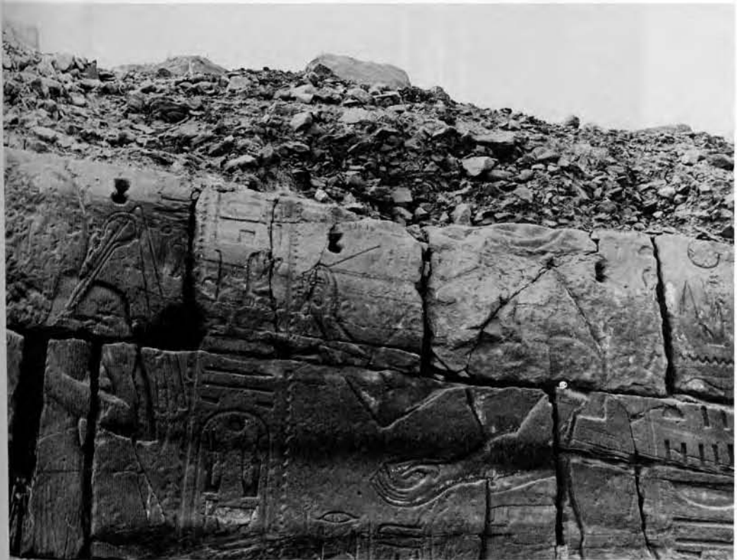
Pl. VI, b. La couche d'éclats scellant le sommet actuel du môle est du IX e pylône, vestige du remplissage de sa partie haute. Cl. M. Azim.
