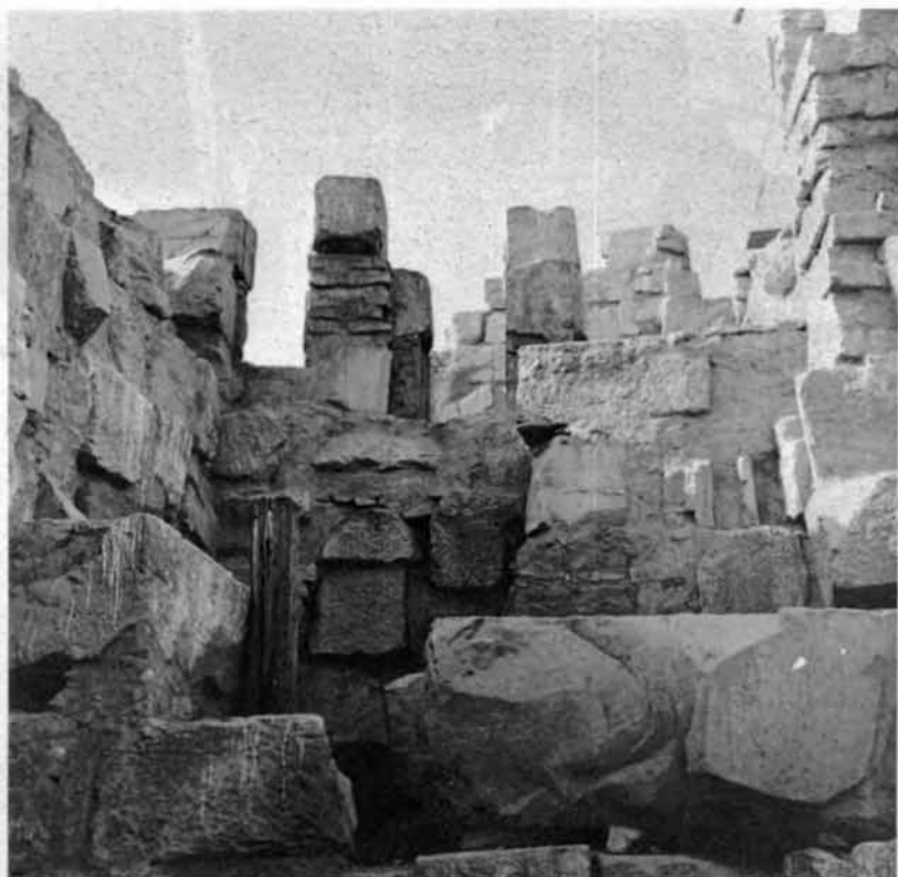
Pl. IV, a. La partie haute du montant nord de la porte du II e pylône, vue depuis l'intérieur du môle nord. La baie rectangulaire qui subsiste (au centre de la photo) correspond à la porte d'arrivée de l'escalier du pylône sur les linteaux du passage. A sa gauche, une autre baie plus étroite et au seuil plus élevé marque le départ d'une courte volée d'escalier en retour donnant accès jadis à la terrasse du môle nord. Cl. M. Azim.
