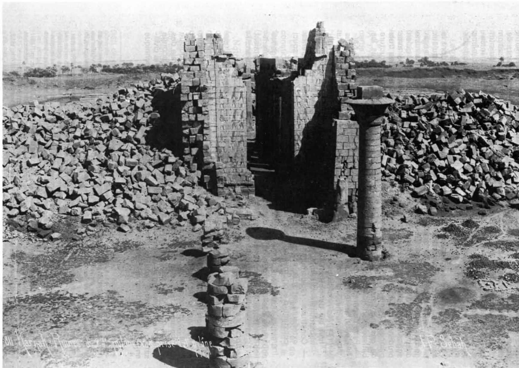
Pl. I. Etat du second pylône à la fin du siècle dernier, avant les premiers travaux. Cl. J.-P. Sebah, n° 811.
