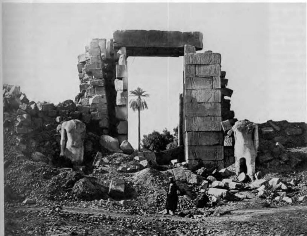
Pl. X, b. Un cliché ancien montre bien le montant est de la porte de granit du X e pylône doublé par un mur de grès exactement appareillé comme les parements du pylône, un vide séparant les deux éléments.
