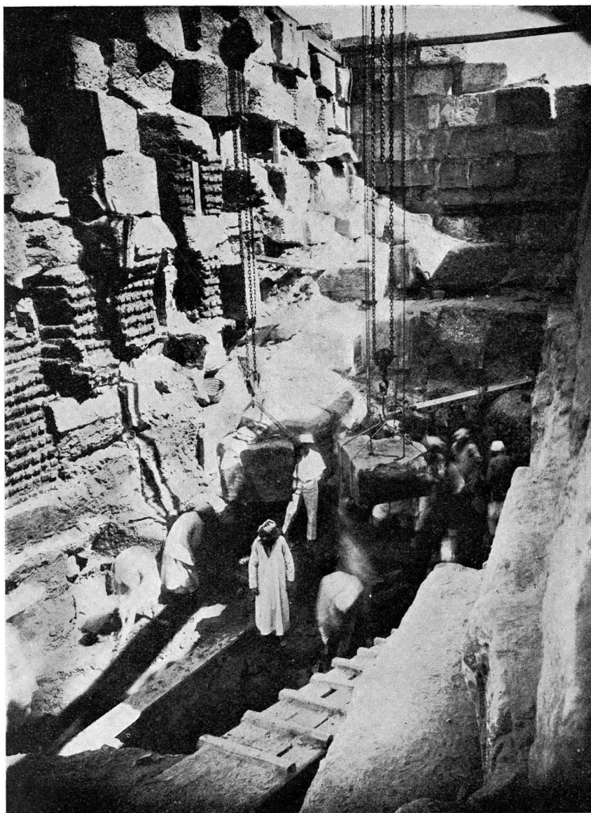
Extraction de pierres remployées dans le III e pylône.
