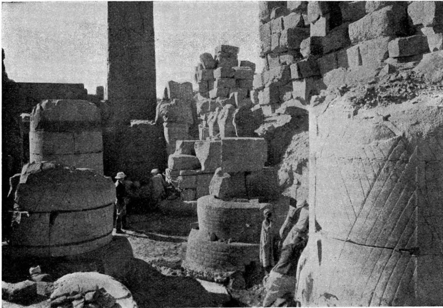
2. Consolidation des colonnes entre le IV e et le V e pylône.
