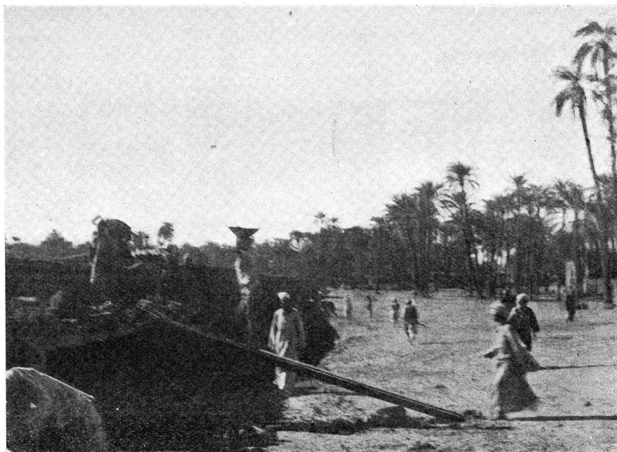
b) Construction du mur d'enceinte ouest.
