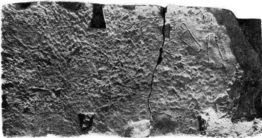
Dalles de la corniche du 1 er pylône montrant les graffitis des pèlerins et les queues d'aronde.
