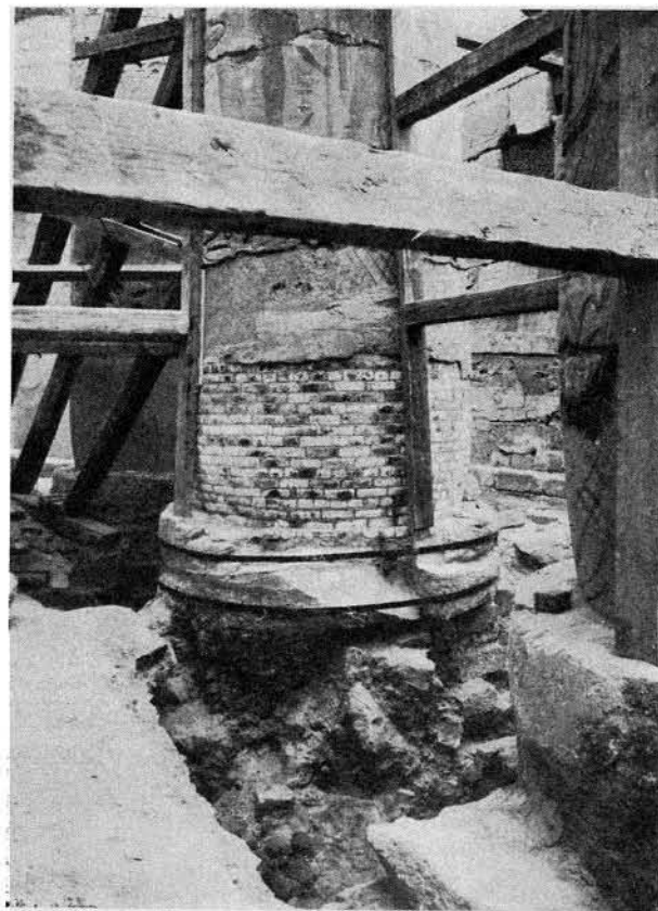
Reprises sous le béton de grès antérieur.
