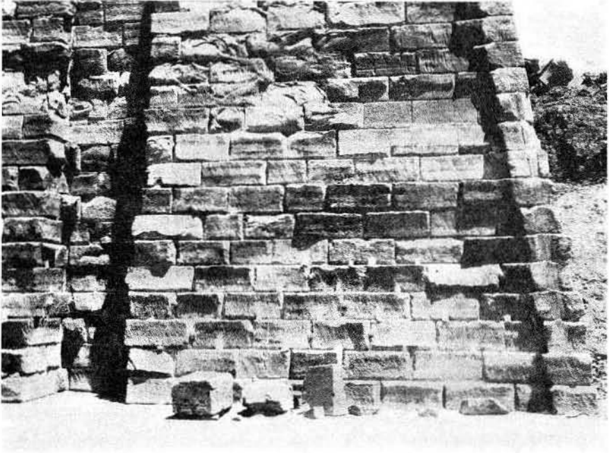
Partie inférieure sud du 1 er pylône, montrant les attaches en plâtre.
