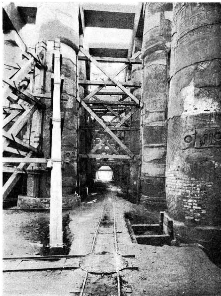
Vue générale des étais dans l'allée transversale.
