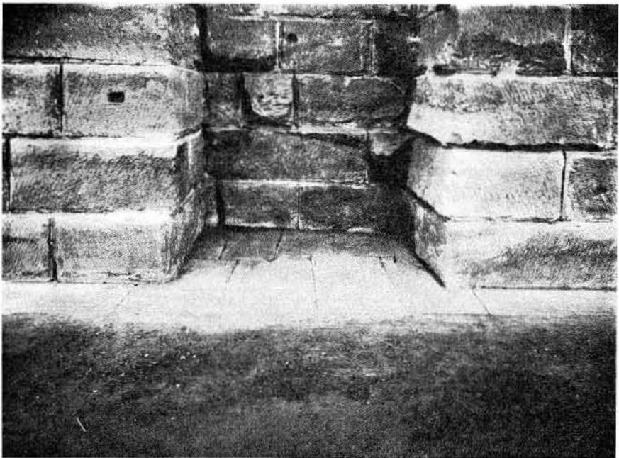
Base du pylône, montrant le rebord qui a indiqué le niveau du sol antique, extérieurement et dans la Grande Cour.
