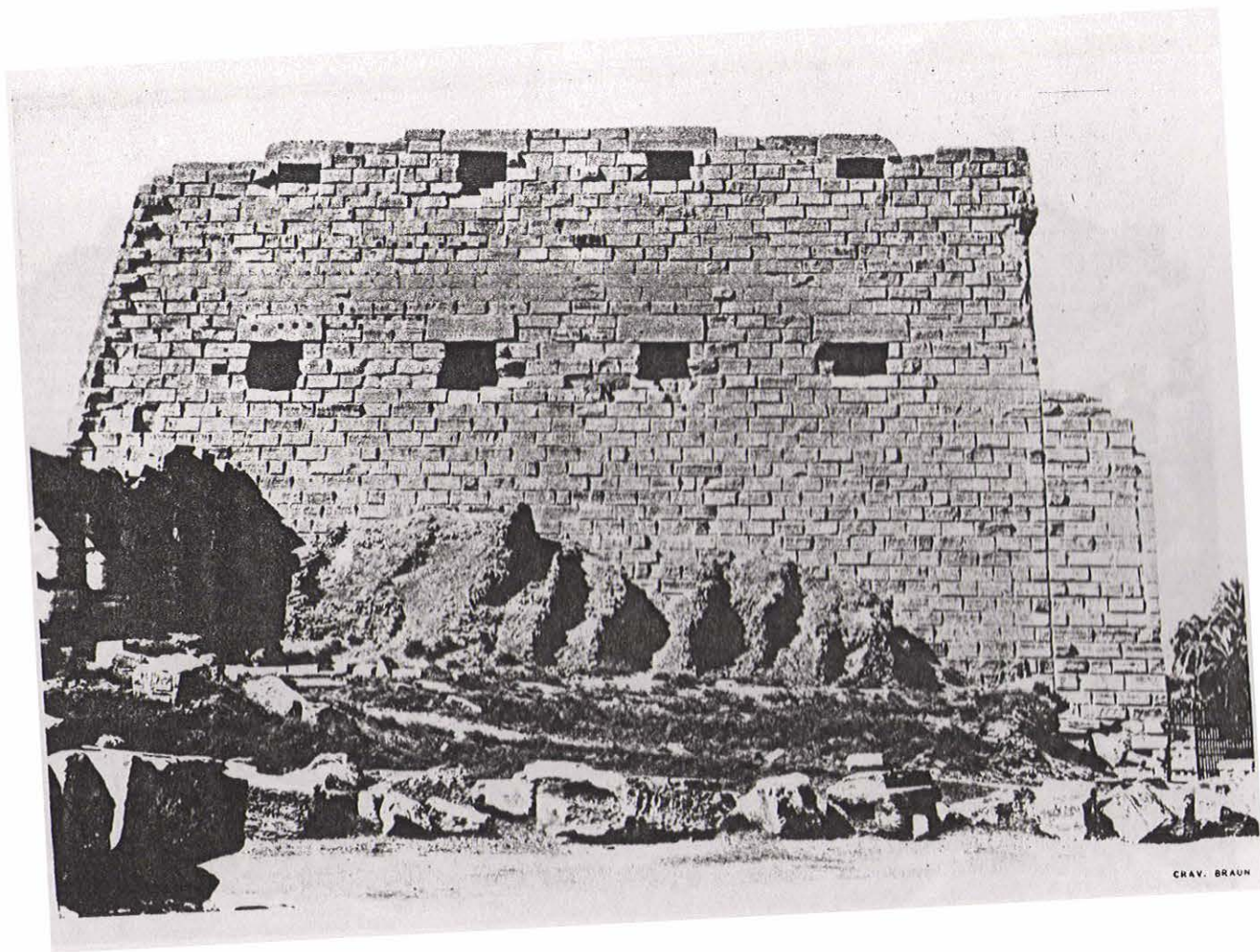
GRAND PYLONE DE L'OUEST, en 1921. Massif sud, face est.
