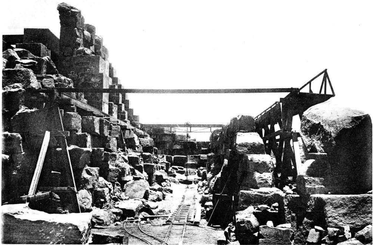
L'aile nord du III e pylône vidée jusqu'à son extrémité nord.
