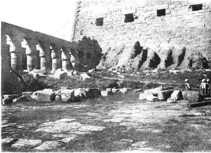
L'angle S.-O. de la Grande Cour avant le début des travaux.
