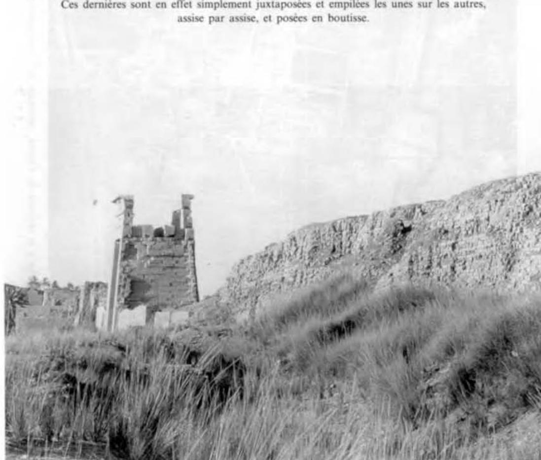
b. Le mur d'enceinte s'adossait à l'origine sur toute la hauteur de la Porte de l'Est, comme le montre bien ici l'une de ses parois latérales non ravalée. Le parement de ses blocs est à l'état brut alors que les faces visibles de la porte ont été lissées et partiellement décorées.
