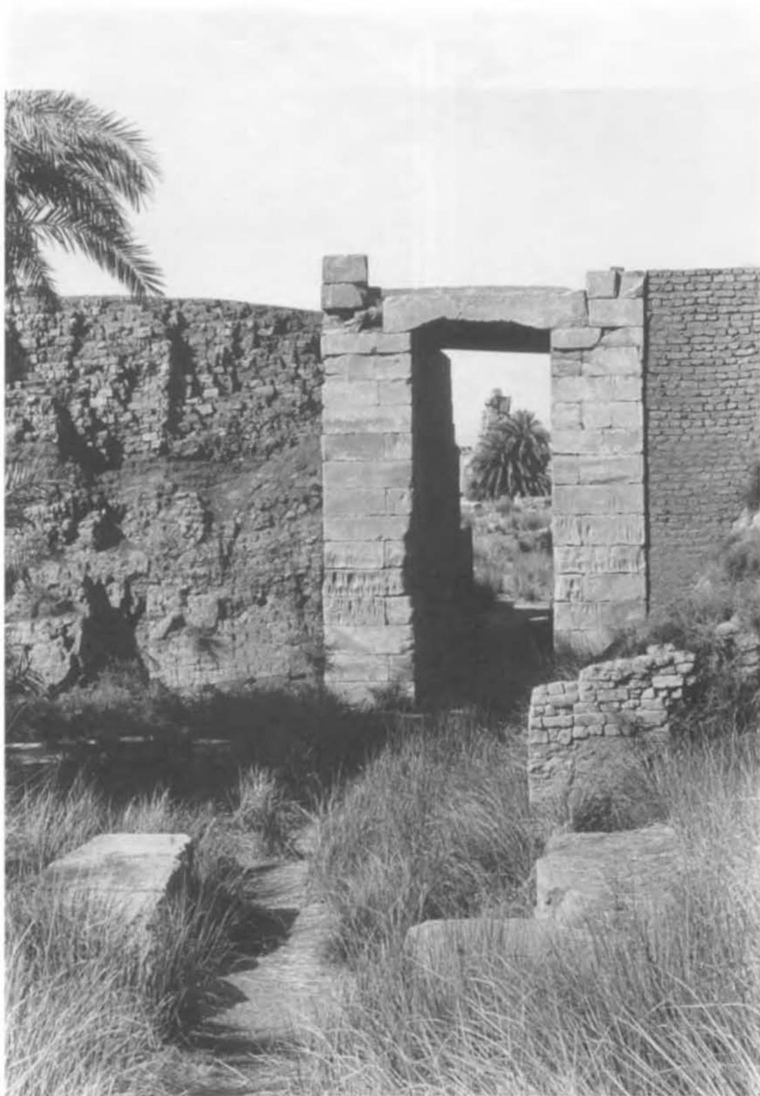
Porte nord de l'enceinte d'Amon. On remarque (sur la gauche) que le joint marquant l'extrémité du dernier massif de l'enceinte penche du côté de la porte. Ce massif prenait appui sur le raccord de briques crues situé entre son joint incliné et la porte de pierre. La porte ne peut donc pas être plus récente que le massif car, si elle n'avait pas existé, l'extrémité de ce dernier se serait effondrée.
