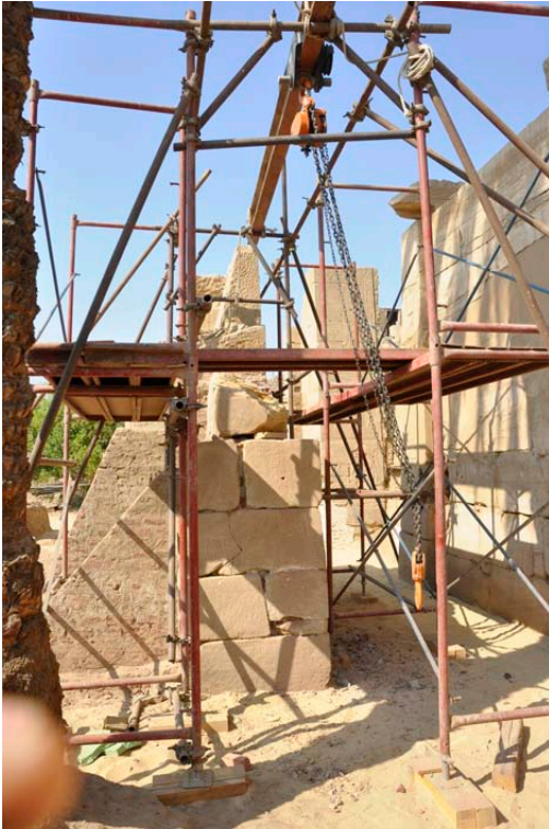
Restauration du montant intérieur sud de la deuxième porte et ajout de trois blocs épars © Cnrs-Cfeetk/Chr. Thiers.
