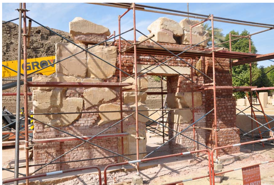
Vue générale d'un mur du Netjery-menou en cours de reconstruction © Cnrs-Cfeetk/A. Garric.
