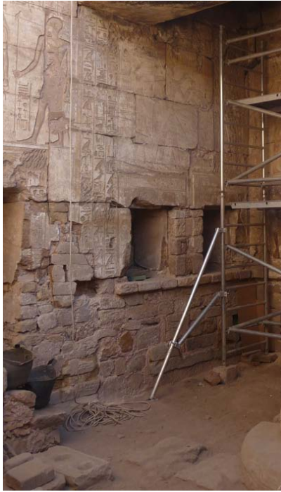
Mur nord de la cour après enlèvement des anciens ciments et mise en place du mortier à la chaux © Cnrs-Cfeetk/Chr. Thiers.
