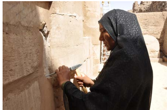
Bloc épars en grès en cours de restauration et retrait des anciens mortiers dans le temple © Cnrs-Cfeetk/O. Bergès.
