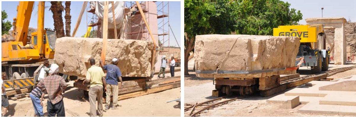
Déplacement du bloc de 45 tonnes appartenant à la couverture de la chapelle de Thoutmosis III © Cnrs-Cfeetk/A. Garric.
