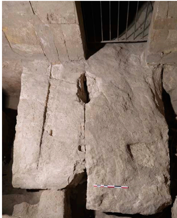
Dalles de plafond en calcaire employées dans le dallage de la chapelle centrale © Cnrs-Cfeetk/J.-Fr. Gout.
