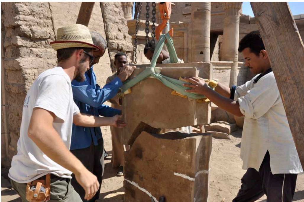
Restauration de partie supérieure brisée de l'autel © Cnrs-Cfeetk/A. Garric.
