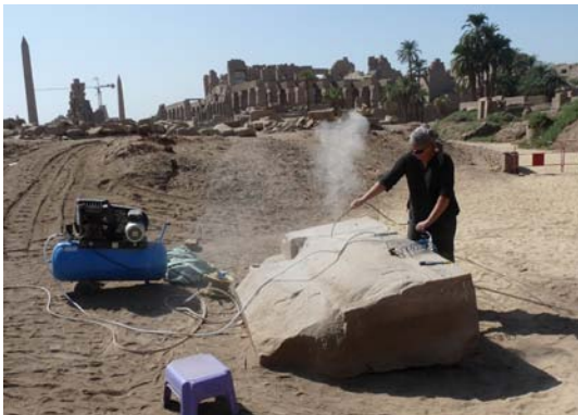
Bloc épars en grès en cours de restauration et retrait des anciens mortiers dans le temple © Cnrs-Cfeetk/O. Bergès.
