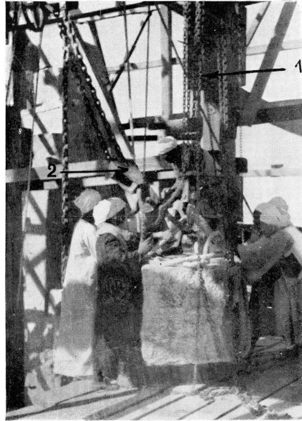
B. Transbordement d'un bloc du pont roulant (1) au palan fixe (2).
