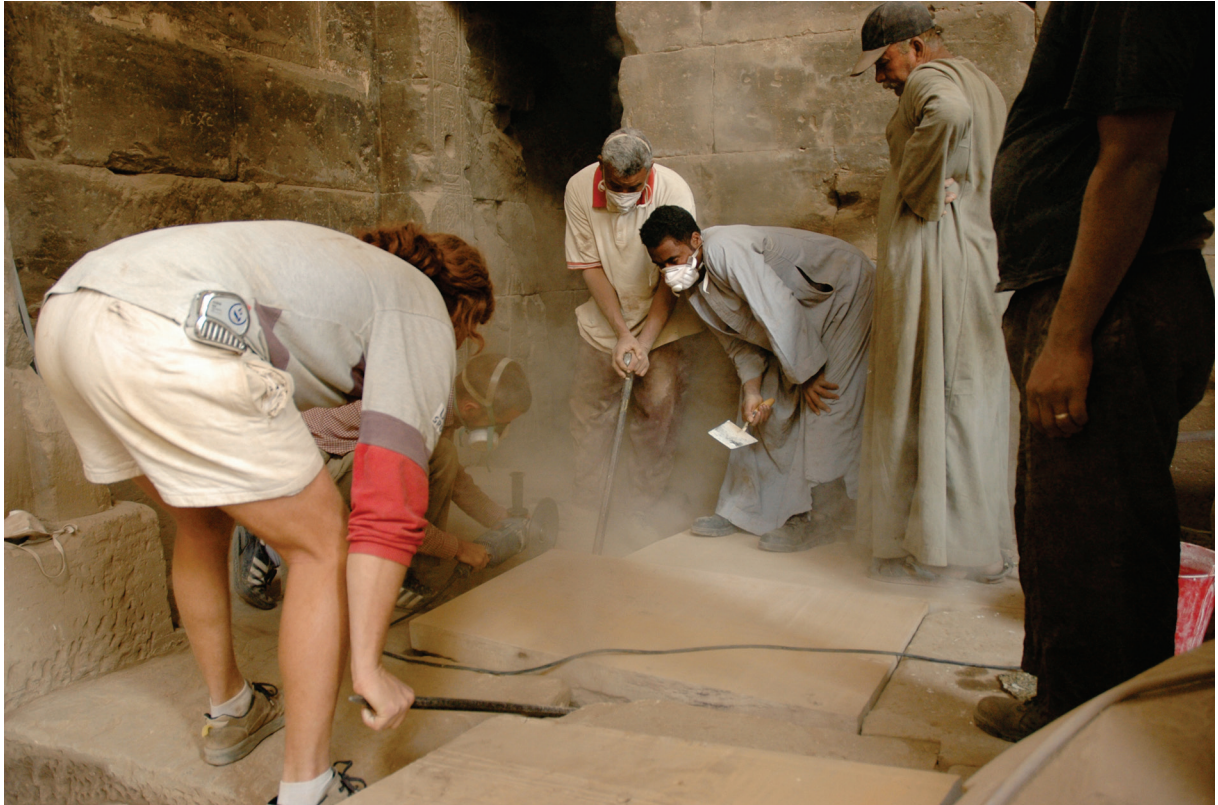
Fig. 3. Installation de nouvelles dalles de grès dans la salle hypostyle. © Cnrs-Cfeetk/Y. Stoeckel.
