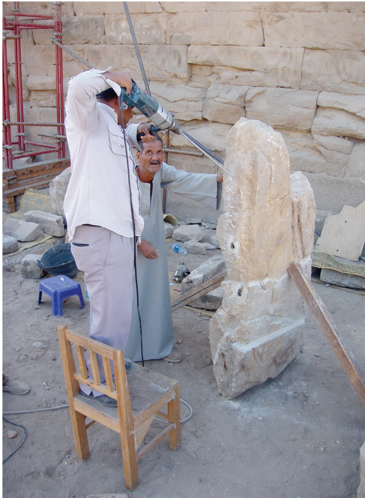
Fig. 21. Mahmud Saïd Ahmed avec l'aide d'Abdou Quoraïem perce le bloc n° 2408. Une tige en acier galvanisé, enrobée dans de la résine, est ensuite insérée dans le trou afin de solidariser les différents fragments. © Cnrs-Cfeetk/E. Laroze.
