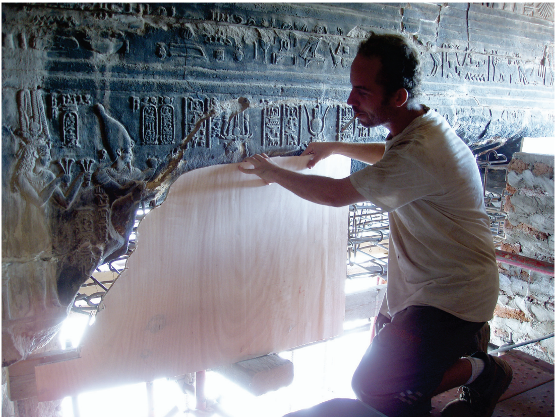
Fig. 11. Les coffrages en bois qui serviront à couler le béton sont préparés pour s'adapter parfaitement aux plans de cassures. © Cnrs-Cfeetk/E. Laroze.
