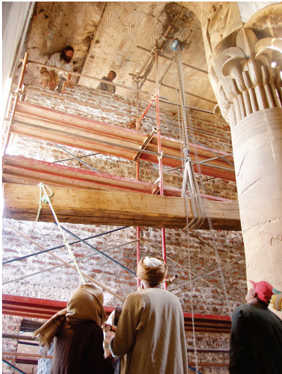
Fig. 8. Le mur de soutènement provisoire en briques dans la salle hypostyle. Une poutre en bois est hissée pour être placée sous le plafond afin de répartir convenablement les charges sur le mur. © Cnrs-Cfeetk/E. Laroze.
