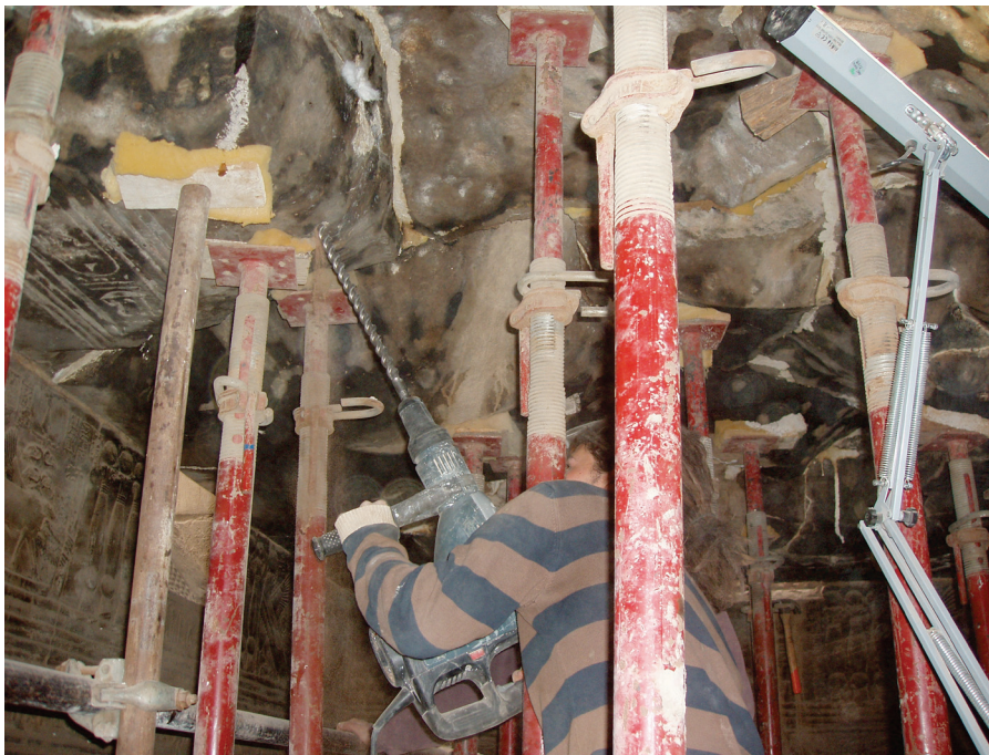
Fig. 13. Pour renforcer le plafond de la salle des offrandes des conduits sont percés afin d'y introduire des tirants métalliques. © Cnrs-Cfeetk/E. Laroze.
