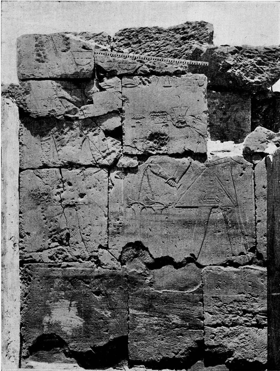
Paroi Ouest de la chambre II.
