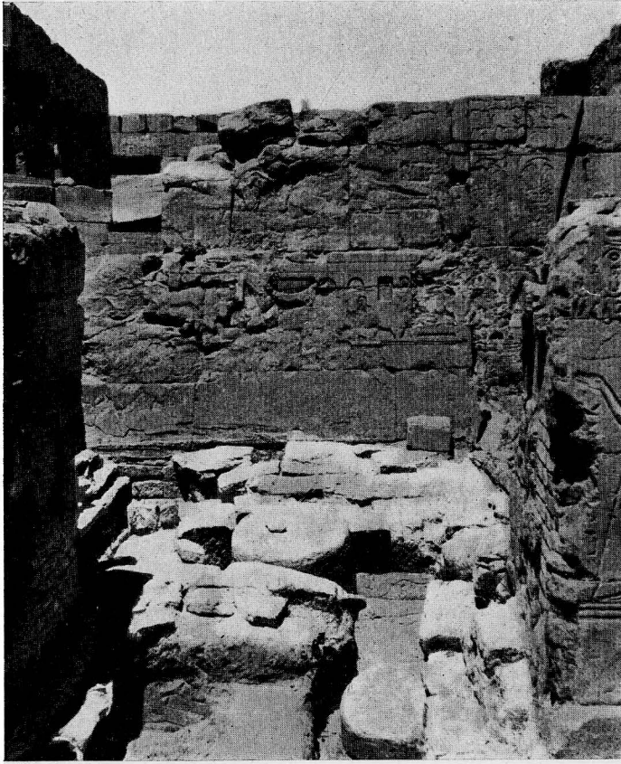
1. — Pierres réemployées ( a, b, c, f, g ) dans le dallage.
