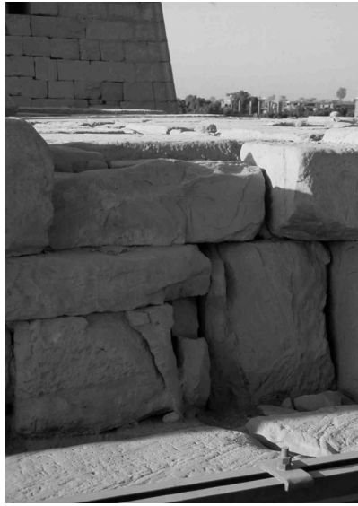
Fig. 7. Toit du temple de Khonsou, escalier ouest.
