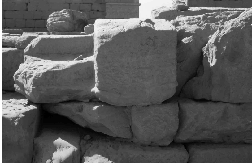
Fig. 6. Toit du temple de Khonsou, escalier est.
