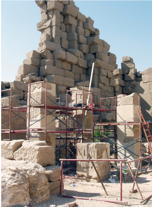
Fig. 10. Les piliers du portique de Thoutmosis IV remontés à leur emplacement d'origine devant le môle nord du IV e pylône (© CNRS-CFEETK/E. Laroze).
