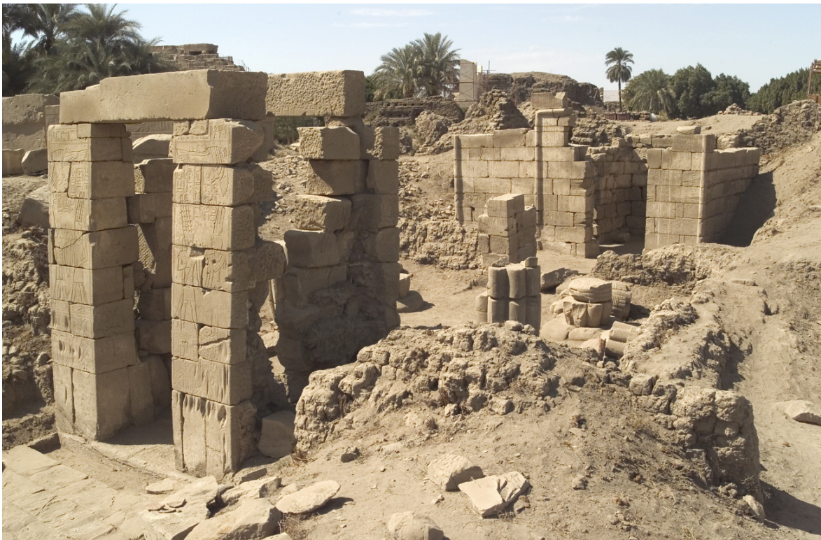
Fig. 12. vue générale la chapelle d'Osiris Ounnefer «maître des aliments» (cliché 77943 © CNRS-CFEETK/A. Chéné).
