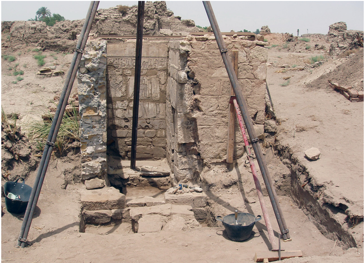
Fig. 13. La chapelle d'Osiris Neb-anekh après le démontage de sa façade (© CNRS-CFEETK/E. Laroze).
