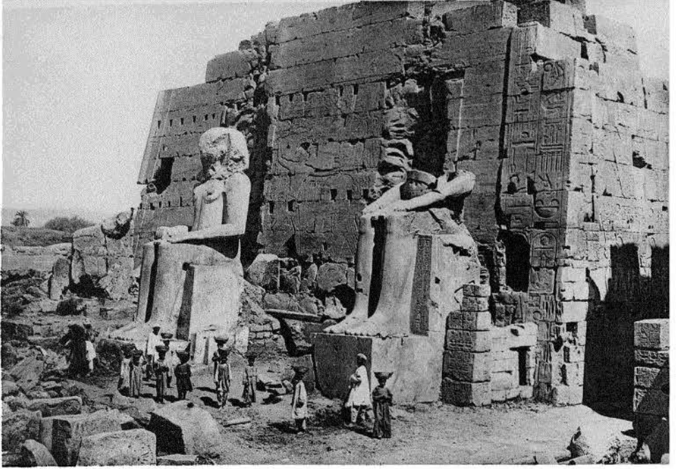
1. Le massif occidental de la façade du VIII e pylône. 12 Avril 1924.
