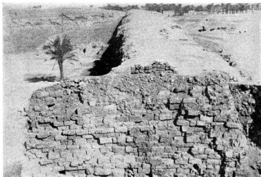
Section du mur d'enceinte de l'Est montrant la courbure des assises.
