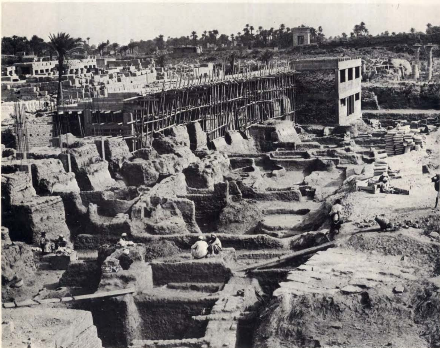
Fouille à l'Est des gradins en construction, cliché A. Bellod.
