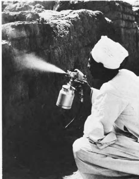
B. – Consolidation d'un mur de brique crue par application d'une résine polyvinylique.
