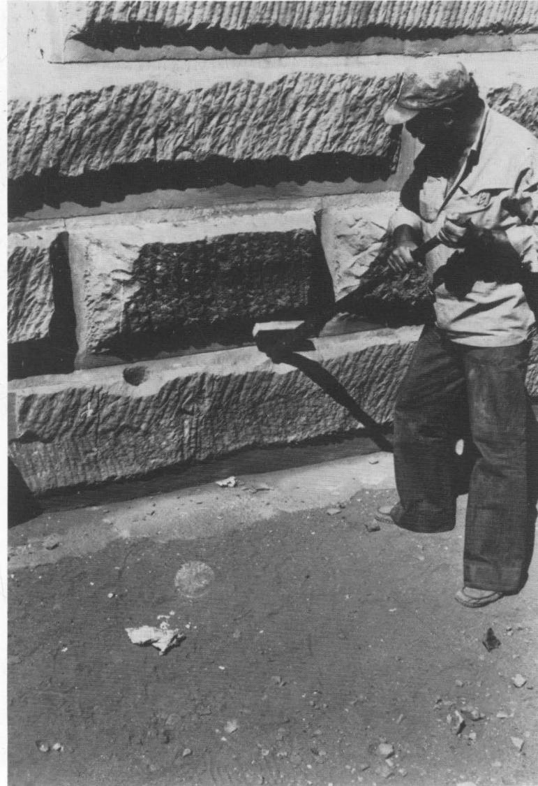
B. — Les leviers servant à repousser les blocs latéralement prenaient appui dans les trous creusés au sommet des bossages.
