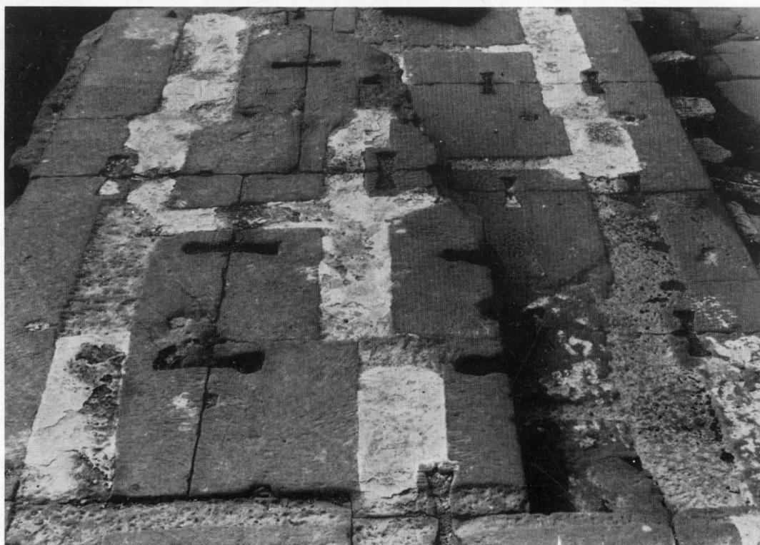
B. — Réseau des canaux horizontaux contenant encore des vestiges du plâtre liquide qui y fut versé au moment de la pose des blocs.
