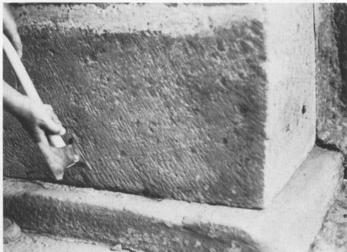
B. — Ravalement du parement à l'aide d'outils au tranchant lisse laissant des marques légères en forme de stries.
