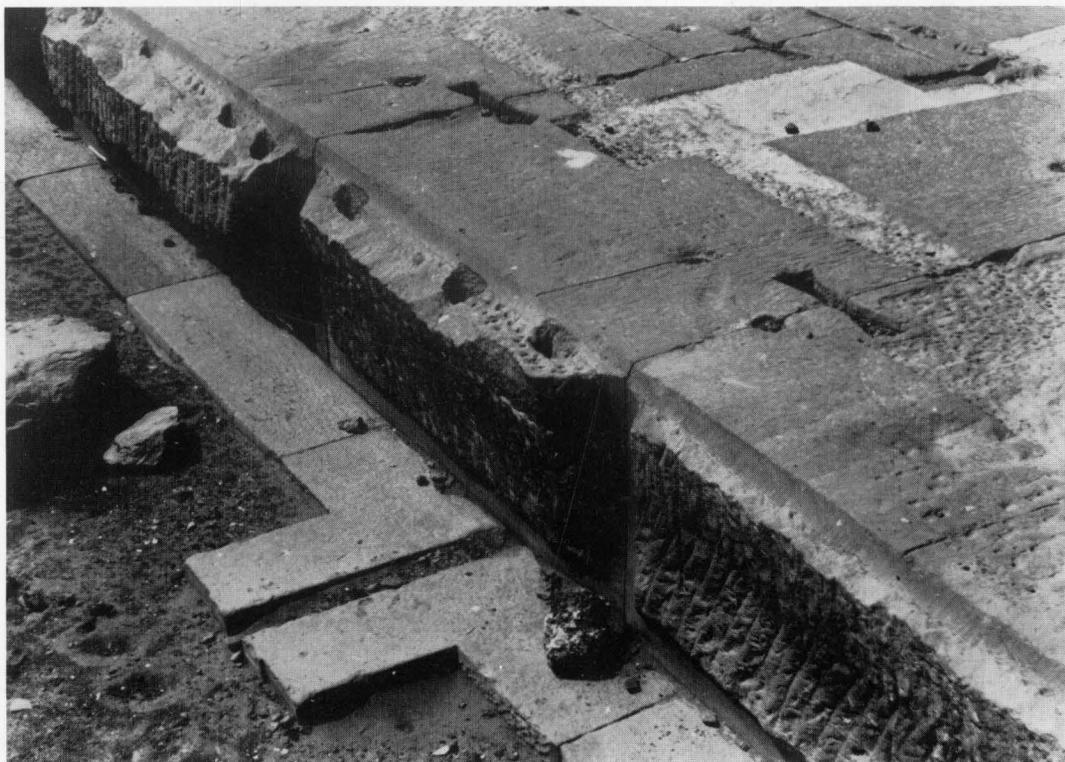
B. — Les trous de levier pratiqués au sommet des bossages sont situés au voisinage des repères indiquant la position des blocs de la future assise.
