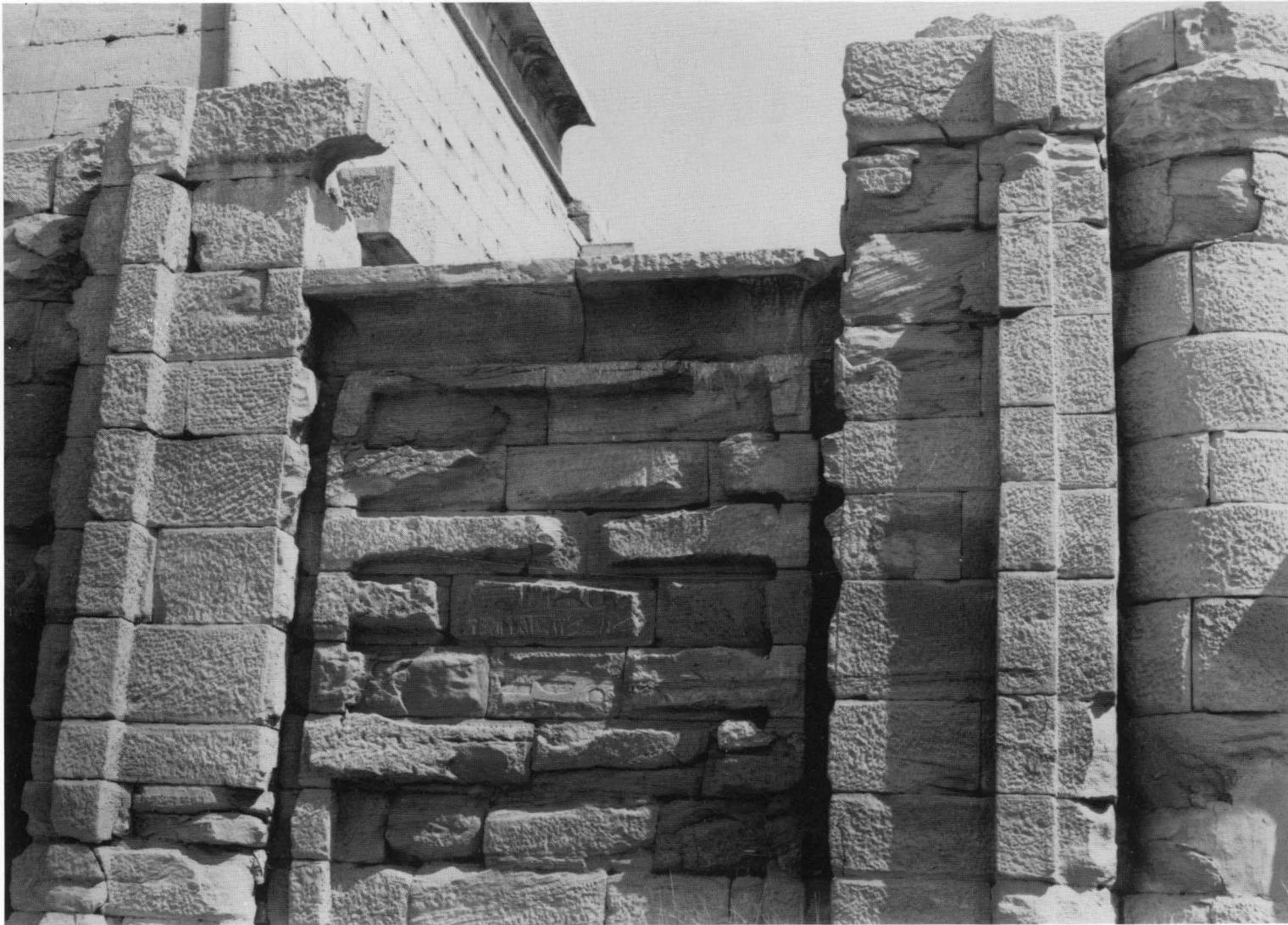
Epannelage des moulures verticales et début du ravalement des parois.
