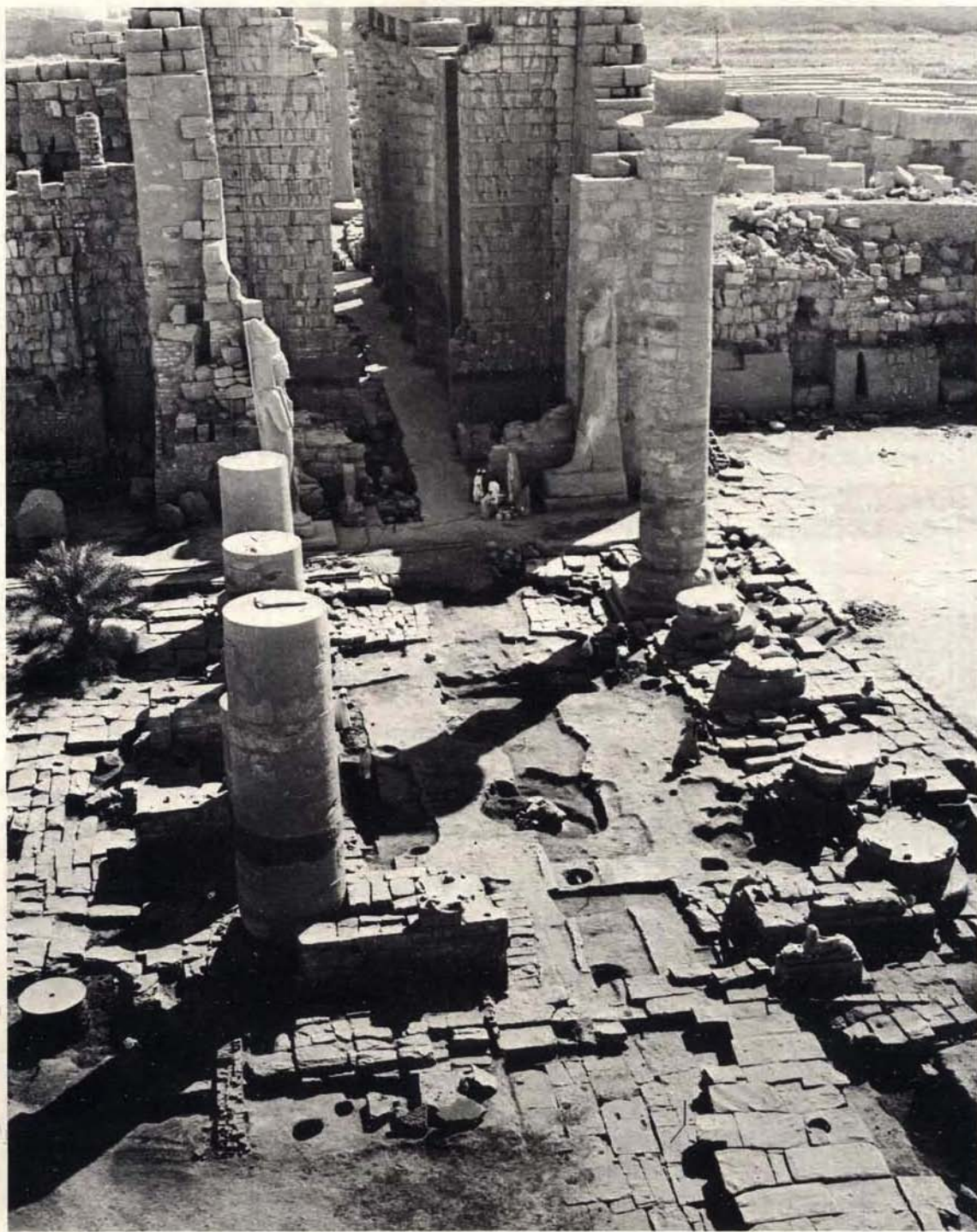
Vue générale du chantier après dépose du dallage et du socle d'albâtre, cliché A. Bellod.
