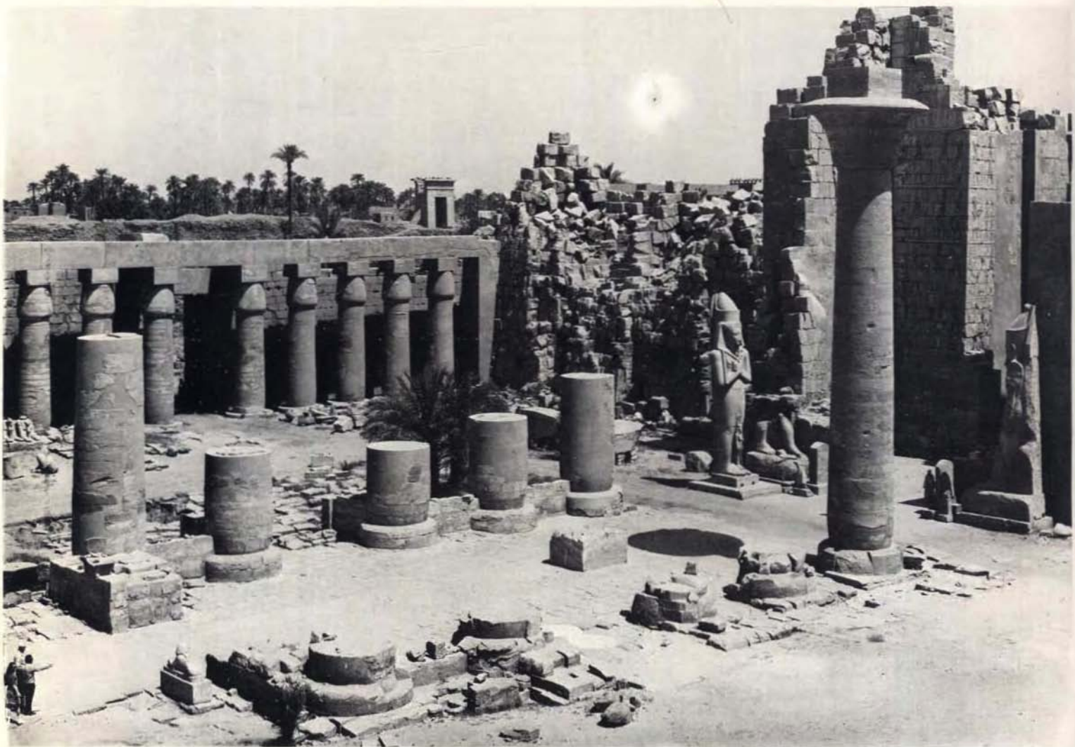
Le kiosque après restauration du dallage et surélévation de l'autel en albâtre, cliché A. Bellod.
