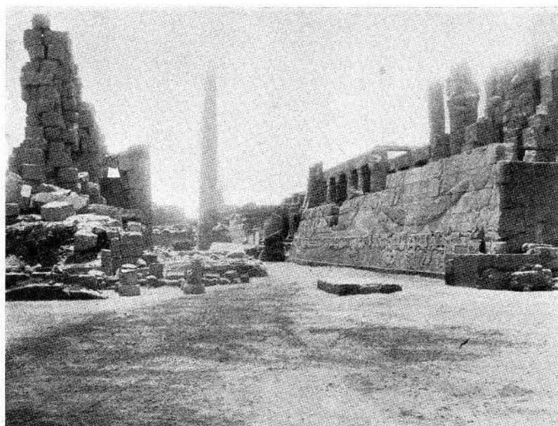
Le déblaiement au Nord des III e et IV e pylônes.
