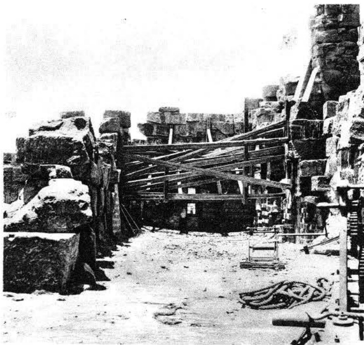
2. Vidage du 3 e pylône.
