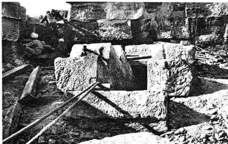
1. Escalier du 3 e pylône en cours de démontage.
