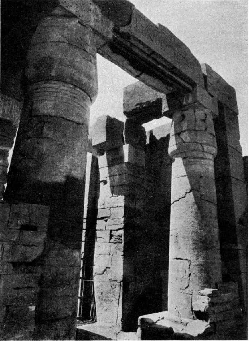
Portique de Sheshonq avant la restauration.
